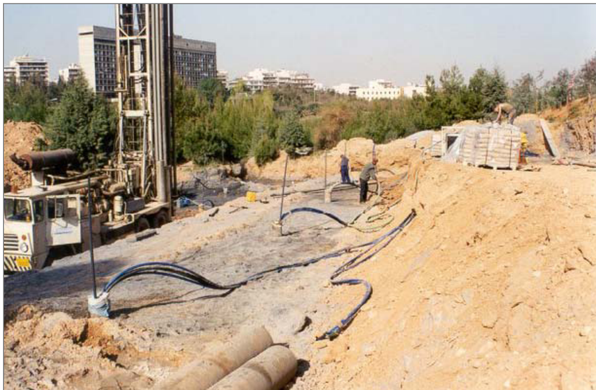
Εικόνα 4-11: Κατασκευή του πεδίου των κάθετων γεωεναλλακτών της γεωθερμικής εγκατάστασης (αρχείο ΕΜΠ)
