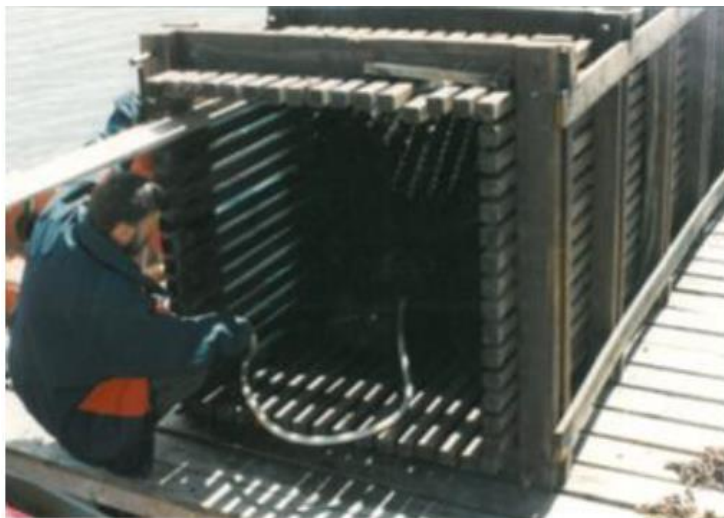
Εικόνα 4.9 : Ηλεκτρόδιο θαλάσσης σε ξύλινο κλουβί και οπτάνθρακα
