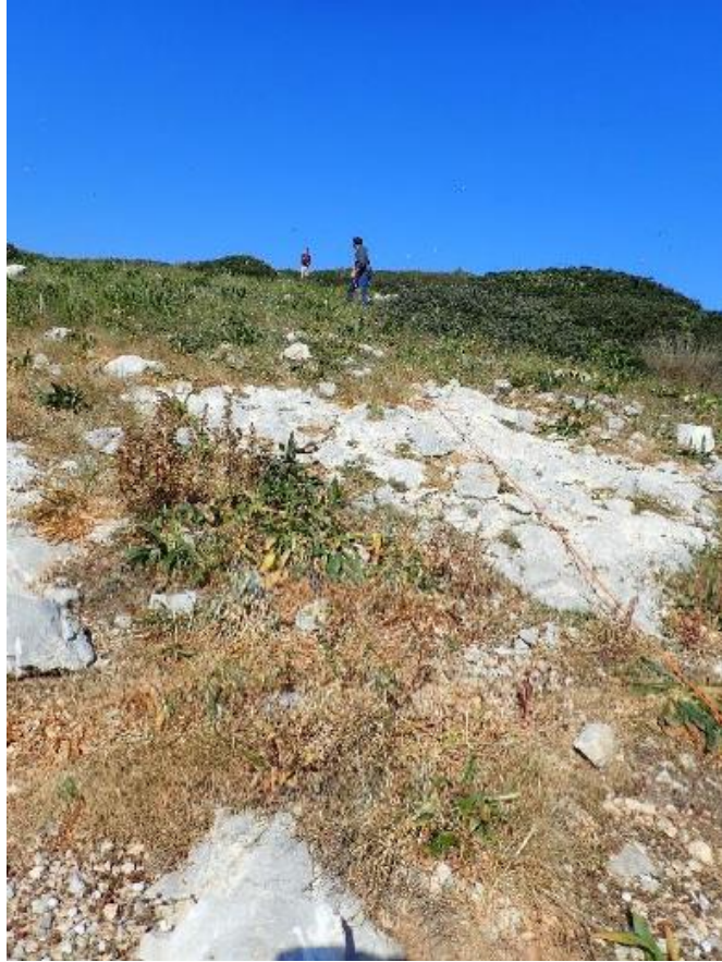
Εικόνα 5.5 : Ξετύλιγμα και τοποθέτηση του καλωδίου κατά μήκος της τομής.
