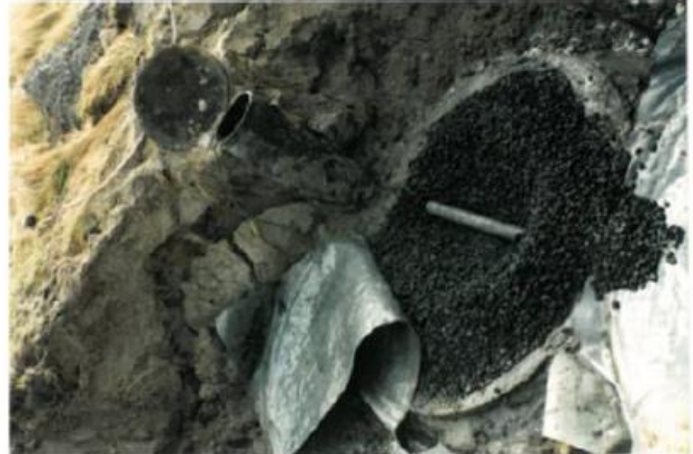
Εικόνα 4.11 : Ηλεκτρόδιο ακτής σε οπτάνθρακα με προστατευτικό κάλυμμα για την αποφυγή της επαφής του οπτάνθρακα με το χώμα.
