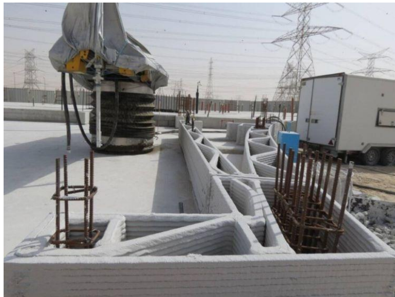
Εικόνα 4 Εκτυπωμένο πλαίσιο με συμβατική σκυροδέτηση
