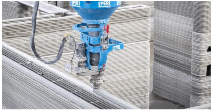
Εικόνα 44 Εκτυπωτής με ανάμειξη στην κεφαλή
