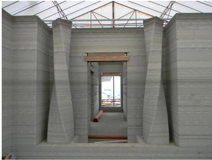
Εικόνα 3 Εκτύπωση In-Situ
