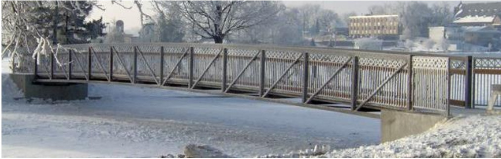
Εικόνα 26 Χρήση δικτύωματος Pratt σε γέφυρα
