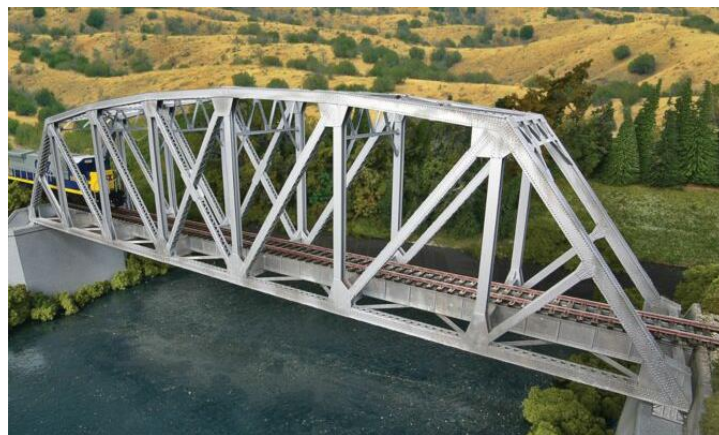
Εικόνα 27 Χρήση δικτύωματος Pratt σε γέφυρα
