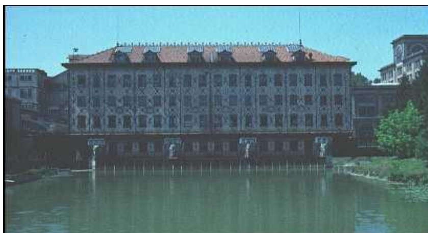
Σχήμα 1.7: Το πρώτο κτίριο με μεταλλικό σκελετό της Γαλλίας, στο Noisiel Sur Marne, Γαλλία, 1872.
