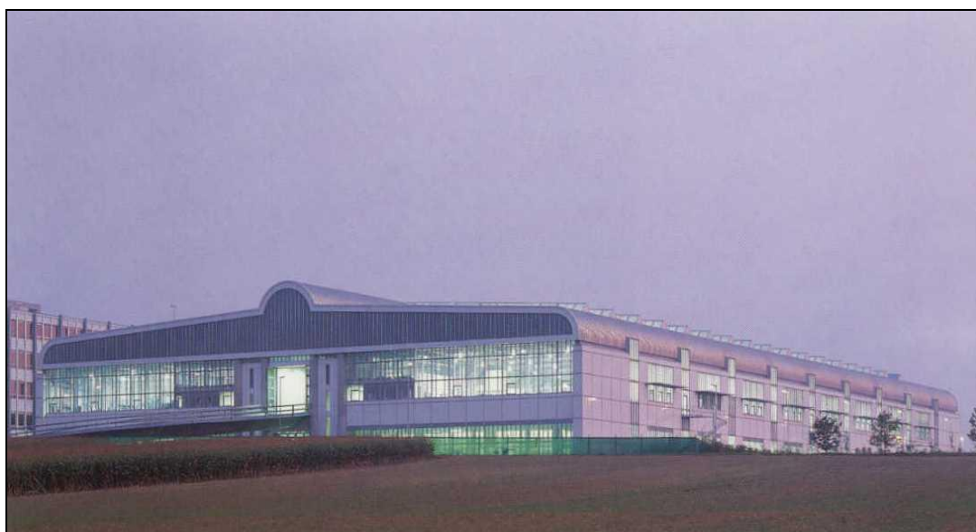
Σχήμα 1.10: Εξωτερική άποψη μεταλλικής κατασκευής αυτοκινητοβιομηχανίας Audi, Γερμανία.
