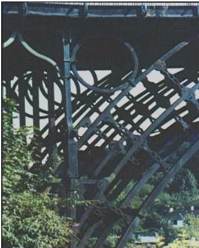
Σχήμα 1.3: Λεπτομέρεια αψιδωτού σκελετού της γέφυρας του Coalbrookdale, Αγγλία, 1777.
