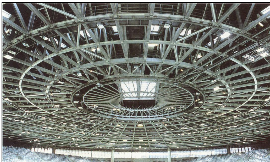
Σχήμα 1.17: Πολύπλοκη δικτυωτή στέγη του ποδηλατικού κέντρου του Βερολίνου, Γερμανία.
