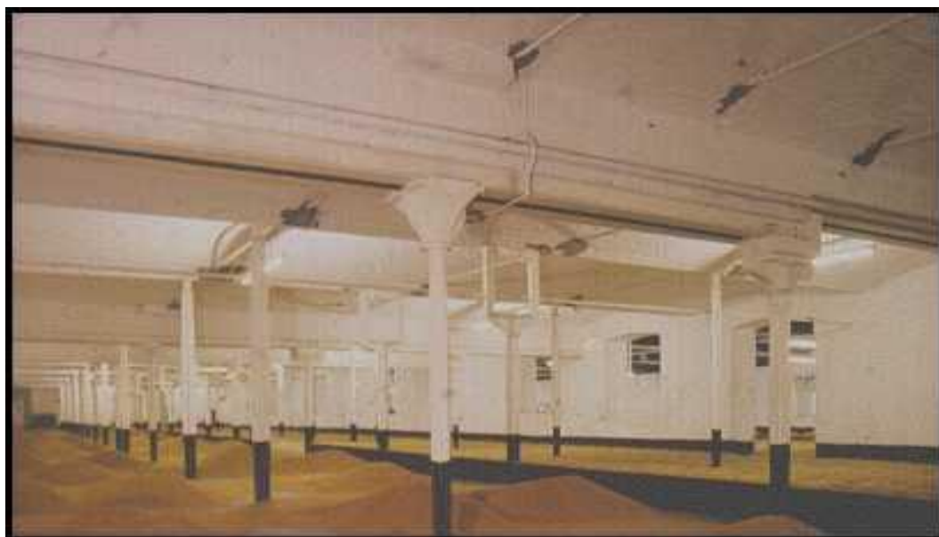
Σχήμα 1.4: Το πρώτο κτίριο με μεταλλικό σκελετό, 1796, Αγγλία.
