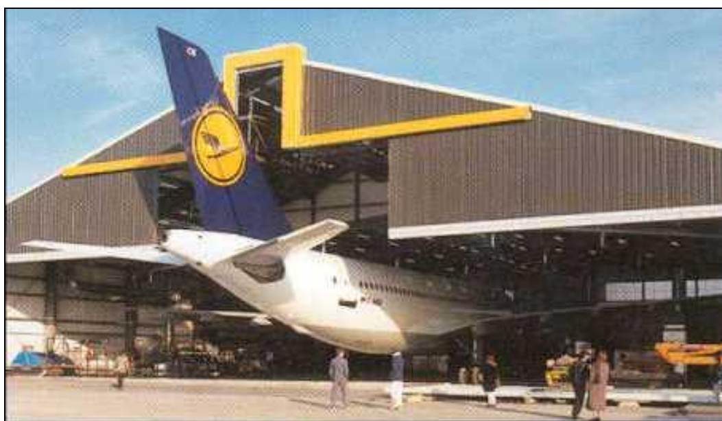
Σχήμα 1.8: Υπόστεγο συντήρησης αεροσκαφών στην Ολλανδία.
