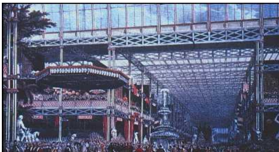
Σχήμα 1.6: Crystal Palace, του Paxton, 3300 μεταλλικά υποστυλώματα, Αγγλία, 1851.
