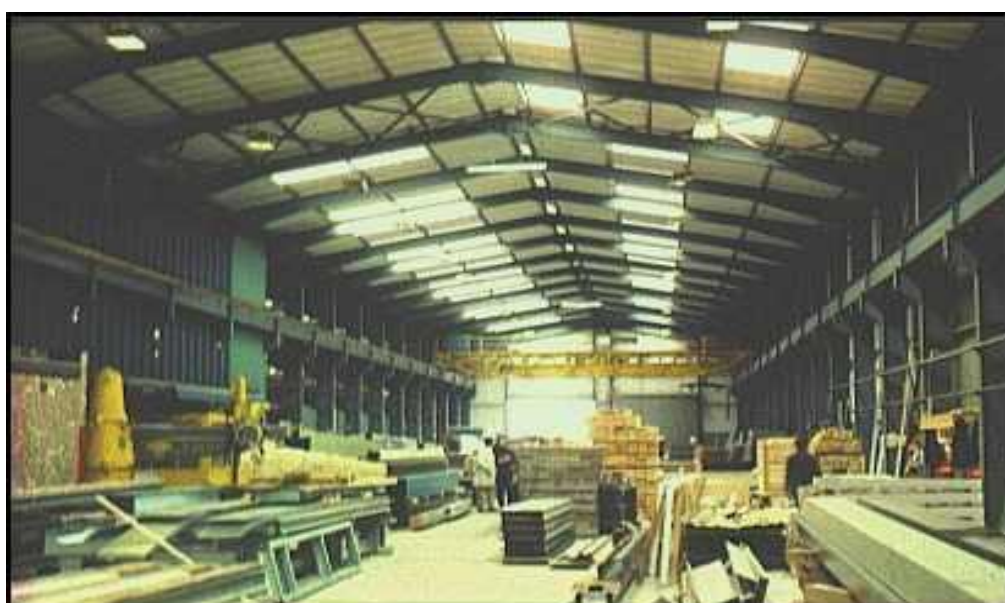
Σχήμα 1.19: Εσωτερική άποψη μεταλλικού υπόστεγου με κινούμενη γερανογέφυρα κατά μήκος της.
