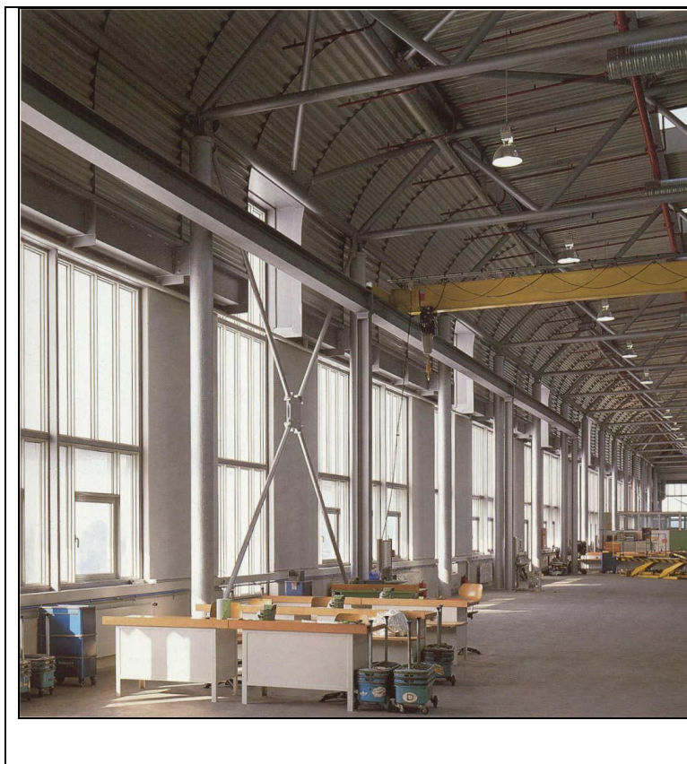
Σχήμα 1.13: Κινούμενη γερανογέφυρα κατά μήκος της βιομηχανίας και τομή της στήριξης του δικτυωτού ζυγώματος.
