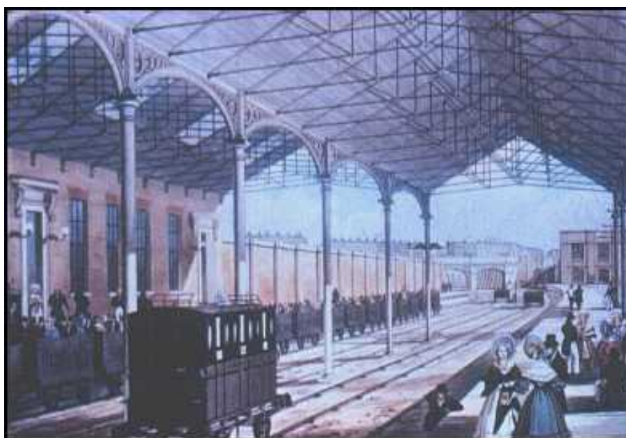
Σχήμα 1.5: Μεταλλικό στέγαστρο του σιδηροδρομικού σταθμού Euston, Λονδίνο, 1837.
