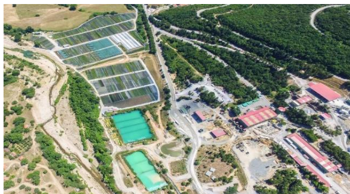
Σχήμα 3.16: Έργο ορυχείου στην περιοχή της Ολυμπιάδας, Χαλκιδικής
