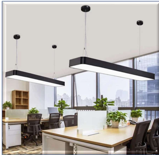
Εικόνα 23: Κρεμαστός άμεσος φωτισμός σε χώρο γραφείων με ψηλό ταβάνι , βοηθάει στην εξοικονόμηση ενέργειας [30].
