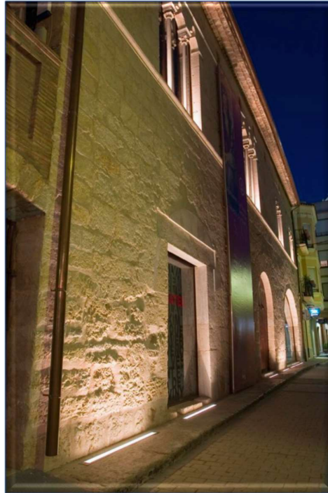
Εικόνα 37: Εξωτερικό φωτισμός Uplighting σε κτήριο [40].
