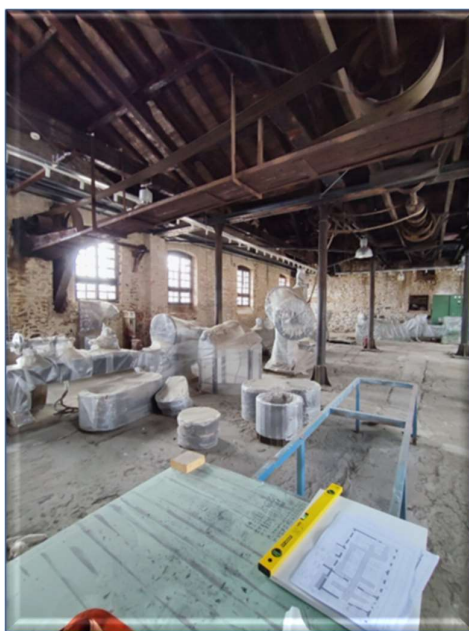
Εικόνα 60: Εσωτερική άποψη μηχανουργείου από την επίσκεψη μας, εκθέματα καλυμμένα για να μην αλλοιωθούν από τις εργασίες, σύγκριση σχεδίων με πραγματικότητα.
