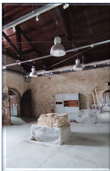
Εικόνα 62: Εσωτερική άποψη μηχανουργείου από την επίσκεψη μας.
