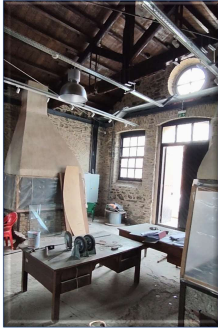
Εικόνα 63: Εσωτερική άποψη μηχανουργείου από την επίσκεψη μας.
