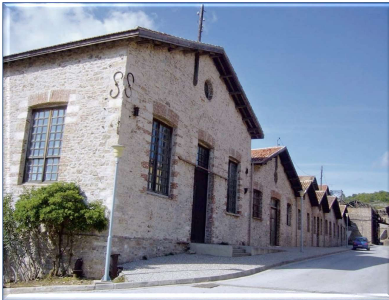
Εικόνα 68: Εξωτερική όψη κτηρίου [53].
