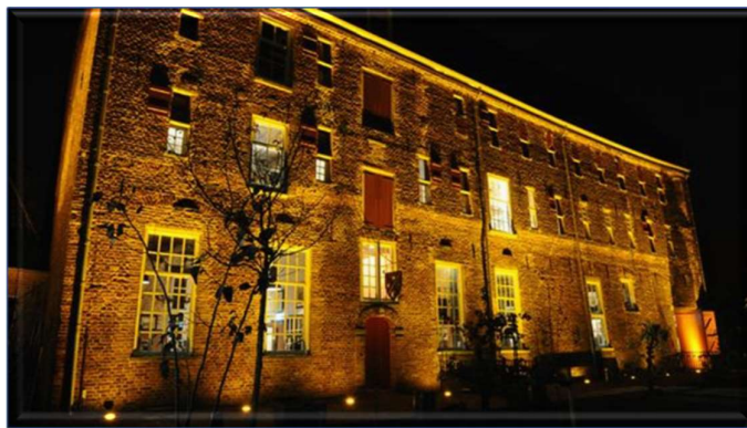
Εικόνα 26: Εξωτερικό φωτισμός κτηρίου με την χρήση προβολέων [33].
