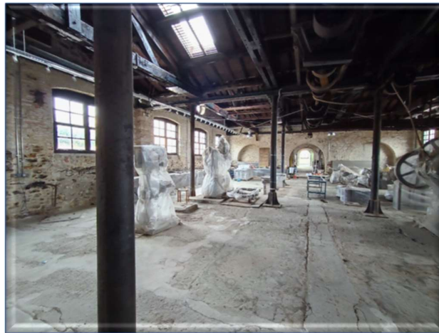
Εικόνα 64: Εσωτερική άποψη μηχανουργείου από την επίσκεψη μας, άξονες και τροχαλίες στην οροφή του κτηρίου.
