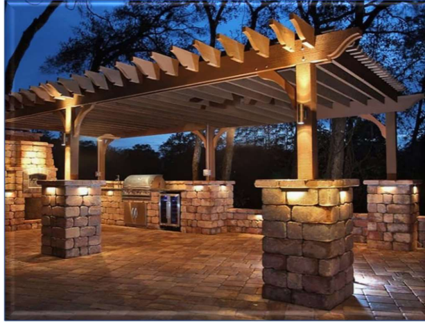
Εικόνα 28: Εξωτερικό φωτισμός κτηρίου με την χρήση προβολέων [34].
