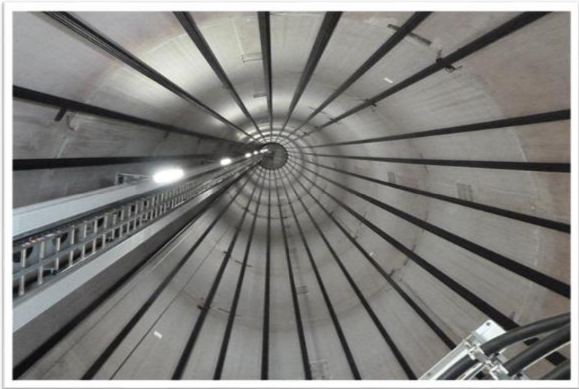
Εικόνα 4.4 Εσωτερική άποψη πυλώνα ανεμογεννήτριας.
