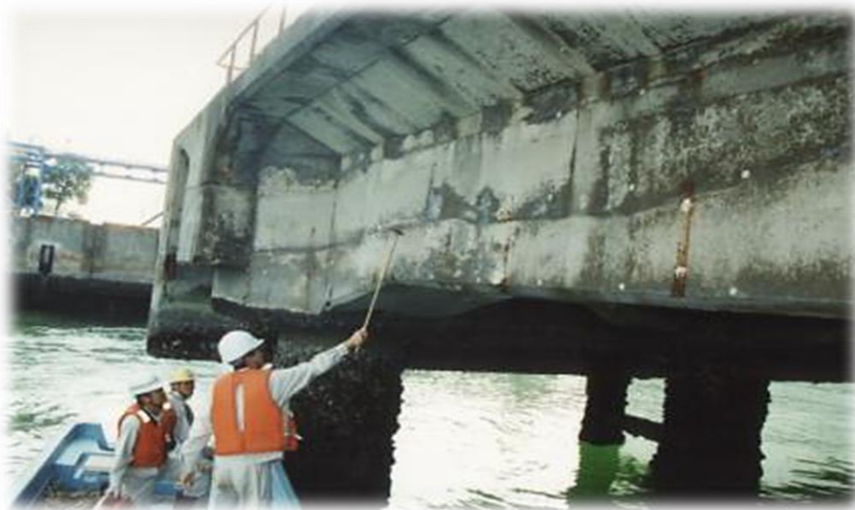
Εικόνα 2.4 Εφαρμογή μεθόδου οπτικής επιθεώρησης σε προβλήτα (Mizuno, 2018).
