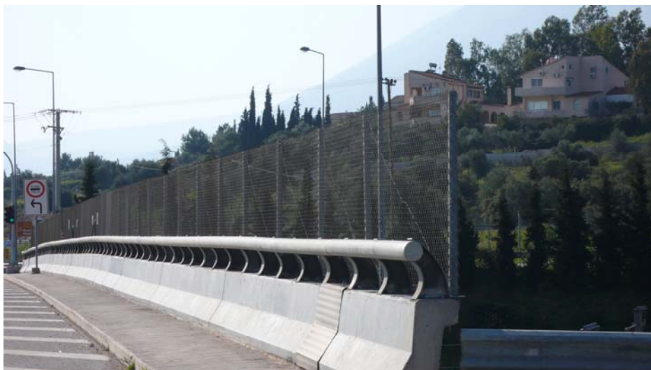
Εικόνα 3.35 Βορειοδυτική πλευρά γέφυρας
