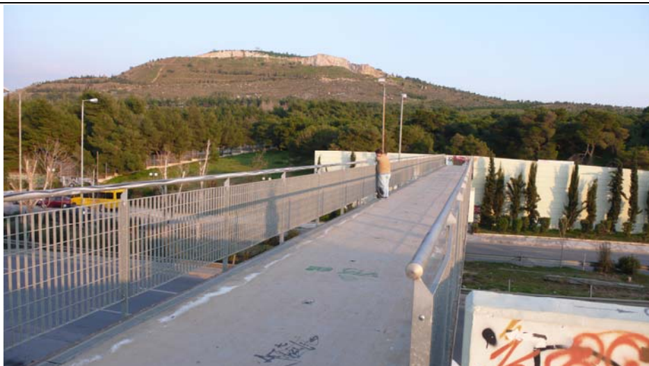
Εικόνα 3.30 Θέση τοποθέτησης φωτογραφικής μηχανής Φ2 – Αριστερή πλευρά προστατευτικών κιγκλιδωμάτων
