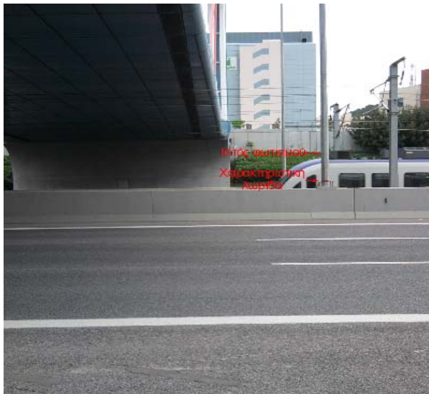
Εικόνα 4.4 Ιστός φωτισμού και χαρακτηριστική λωρίδα υλοποίησης οριζοντίου επιπέδου αναφοράς των μετρήσεων
