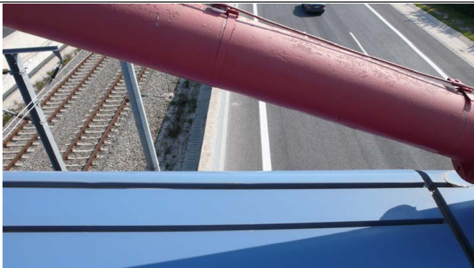
Εικόνα 3.15 Θέση τοποθέτησης σταδίας
