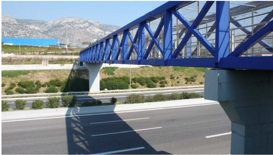
Εικόνα 3.34 Δυτική πλευρά πεζογέφυρας
