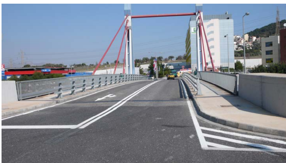
Εικόνα 3.10 Γέφυρα Σ.Ε.Α. Μεσογείων – Αριστερά η δυτική πλευρά της γέφυρας – Δεξιά η ανατολική πλευρά της γέφυρας.
