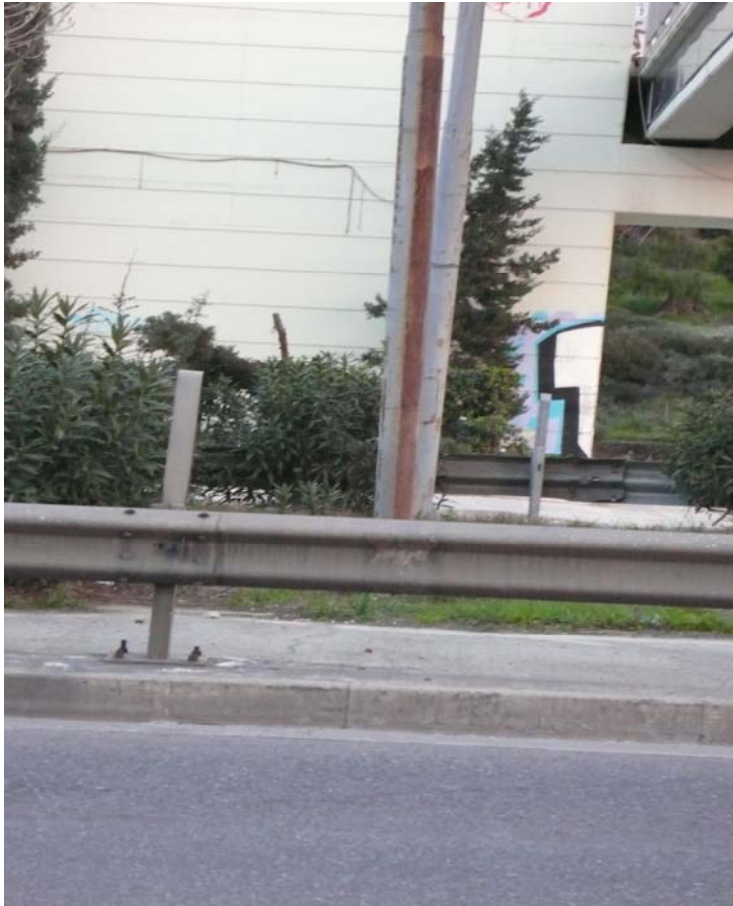
Εικόνα 3.32 Ιστός φωτισμού – Τοποθέτηση σταδίας
