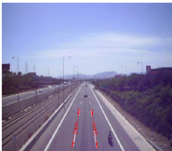
Εικόνα 5.5 Διαμήκης οριζόντια απόσταση στην Αττική Οδό
