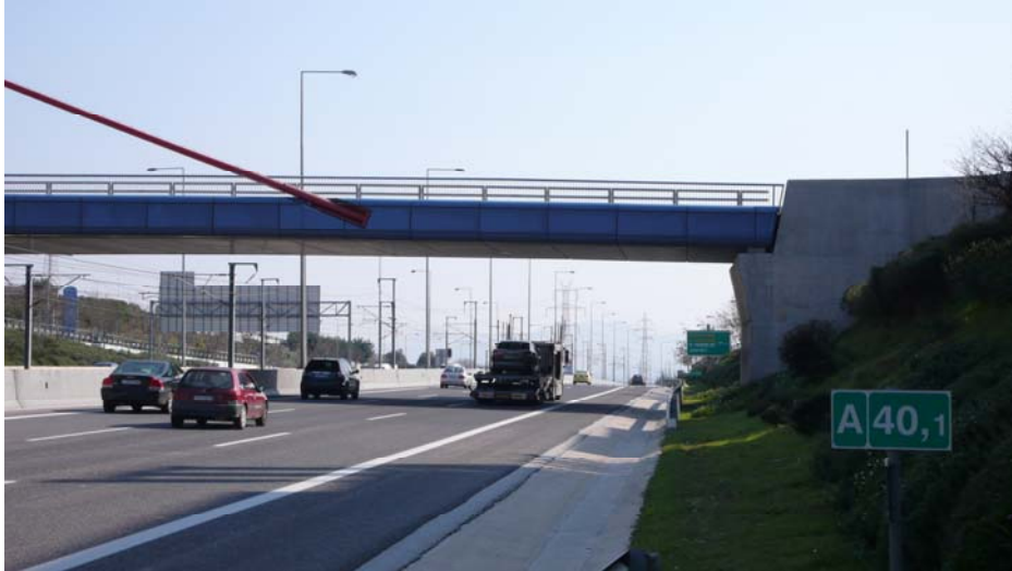
Εικόνα 3.6 Δυτική όψη γέφυρας – Ρεύμα κυκλοφορίας προς Αεροδρόμιο – Μαρκόπουλο
