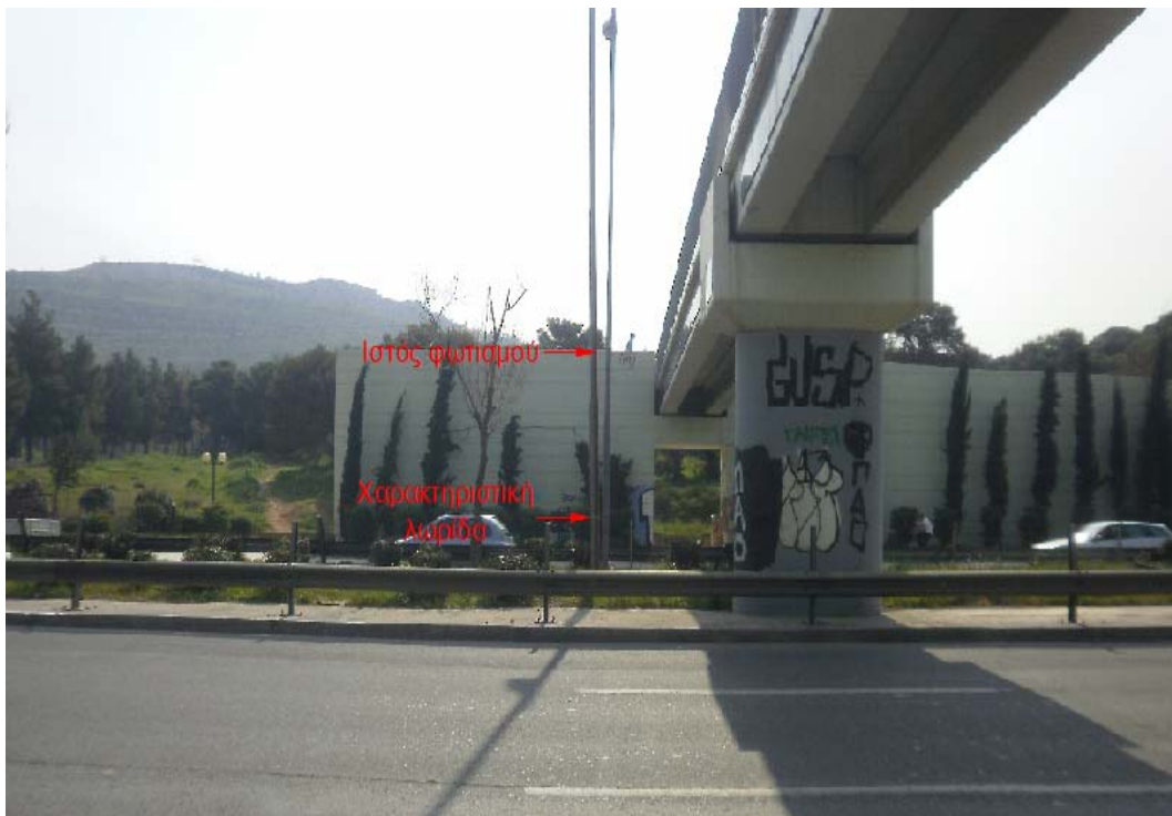
Εικόνα 4.14 Ιστός φωτισμού και χαρακτηριστική λωρίδα υλοποίησης οριζοντίου επιπέδου αναφοράς των μετρήσεων
