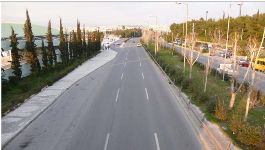
Εικόνα 3.24 Βόρεια πλευρά – Ρεύμα κυκλοφορίας προς Αθήνα
