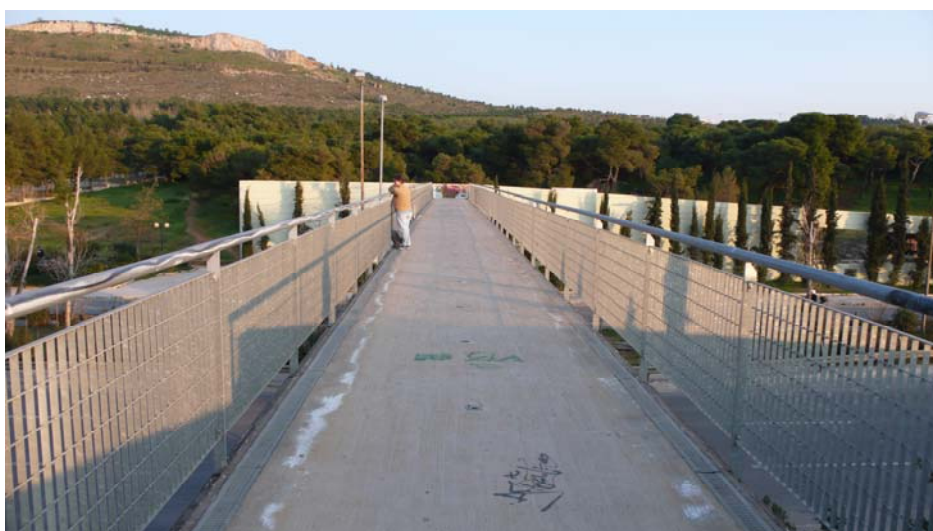
Εικόνα 3.25 Πεζογέφυρα – Αριστερά βόρεια πλευρά – Δεξιά νότια πλευρά
