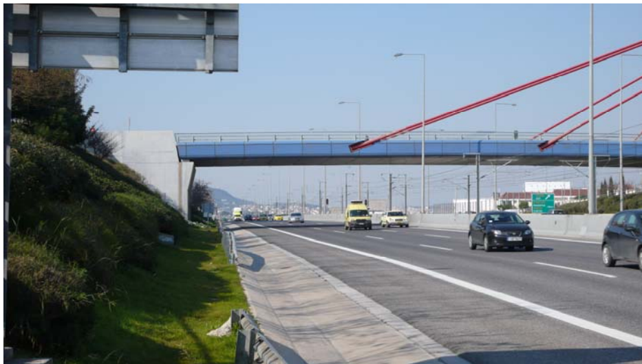
Εικόνα 3.7 Ανατολική όψη γέφυρας – Ρεύμα προς Αεροδρόμιο – Μαρκόπουλο
