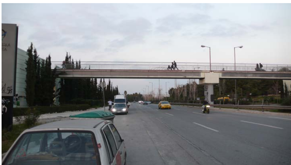
Εικόνα 3.22 Νότια όψη πεζογέφυρας – Ρεύμα κυκλοφορίας προς Αθήνα
