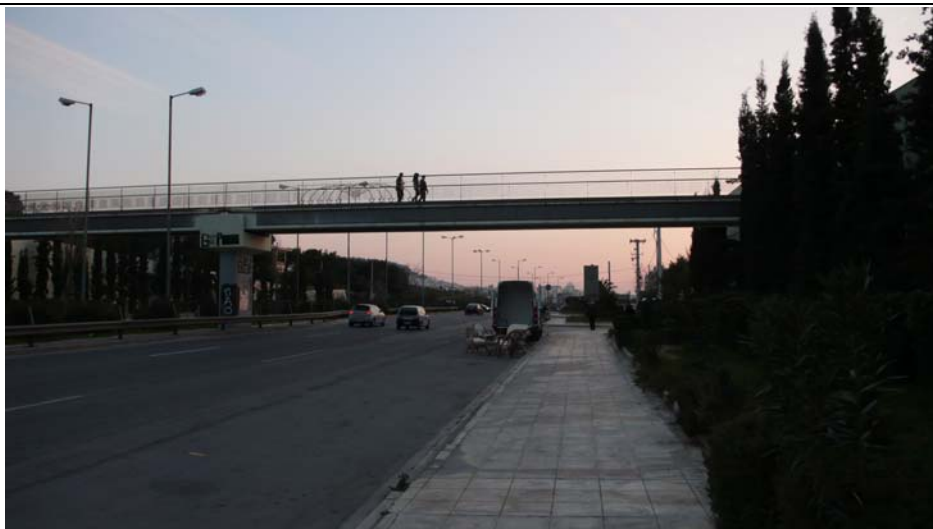
Εικόνα 3.21 Βόρεια όψη πεζογέφυρας – Ρεύμα κυκλοφορίας προς Αθήνα
