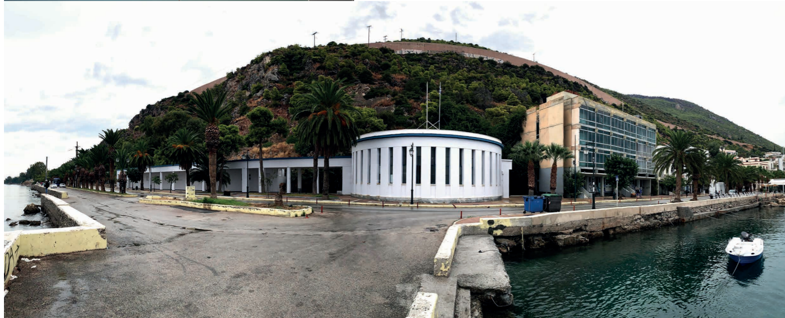
Τα τρία υφιστάμενα Θερμαλιστικά κτίρια, στην περιοχή της παλιάς λουτρόπολης του Λουτρακίου. Στο κέντρο το κυκλικό κτίριο της Ιαματικής Πηγής Λουτρακίου, του 1934.
