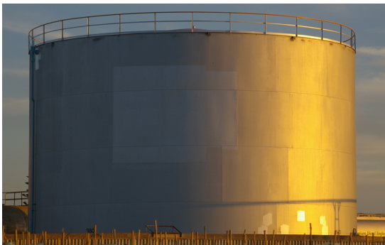
(iii) Μεταλλική δεξαμενή νερού με εξωτερικό κυλινδρικό κέλυφος
