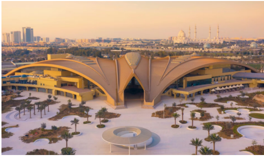
(i) Κελυφωτή στέγη, μεγάλου ανοίγματος
