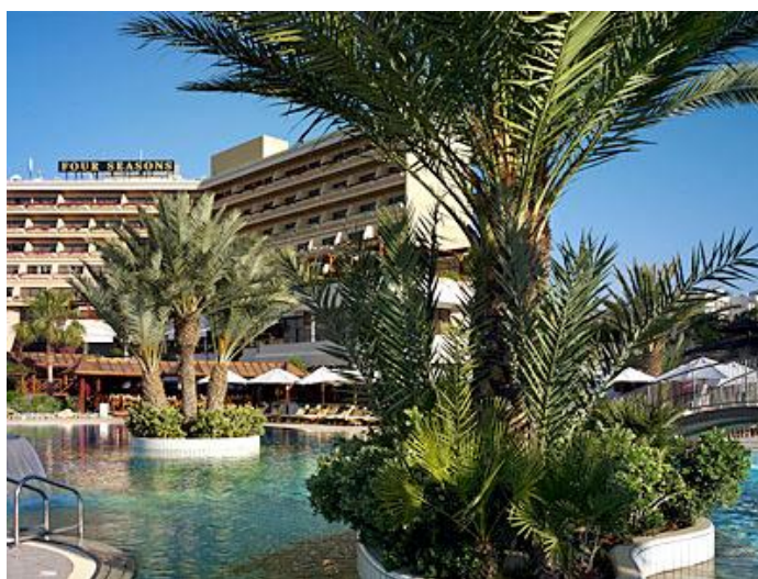
Εικόνα 3.6: Το πολυτελές ξενοδοχείο “Four Seasons” στη Λεμεσό δεν πληροί τους πολεοδομικούς όρους που τέθηκαν για την ανέγερσή του και λειτουργεί από το 1993 χωρίς εξασφάλιση τελικής έγκρισης και χωρίς να εγγραφεί στο κτηματολόγιο.
