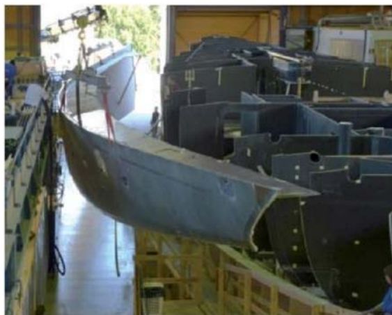
Σχήμα 3-22: Κατασκευή S/Y Pink Gin VI με τη μέθοδο συναρμολόγησης panel. Διακρίνεται ο σκελετός πάνω στον οποίο τοποθετείται το πλευρικό πολύστρωτο πάνελ. (Geuskens et al 2019)
