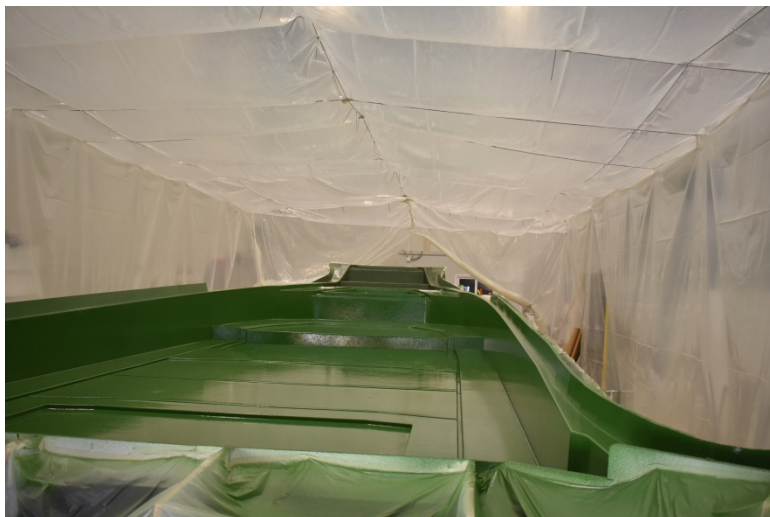
Σχήμα 4-4: Gel coat σε καλούπι υπό κατασκευή
