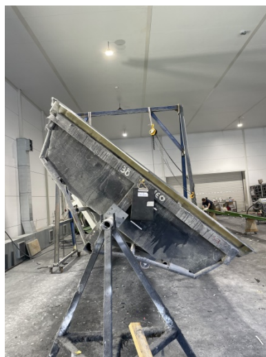
Σχήμα 4-8: Μεταλλικός σκελετός για τη στερέωση των καλούπιών
