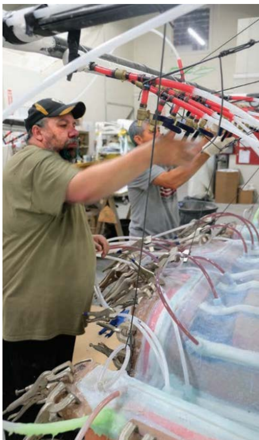
Σχήμα 3-15: Διαδικασία ανοίγματος των σωλήνων τροφοδοσίας
