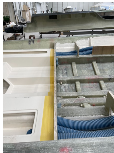
Σχήμα 4-12: Ανοίγματα στη γάστρα για τη διέλευση καναλιών (μπλε εύκαμπτοι σωλήνες)
