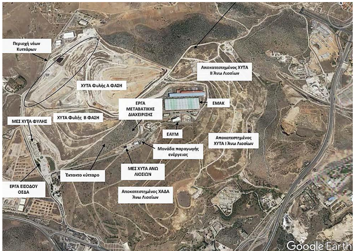
Σχήμα 41. Εγκαταστάσεις στον Χ.Υ.Τ.Α. Φυλής - Άνω Λιοσίων
