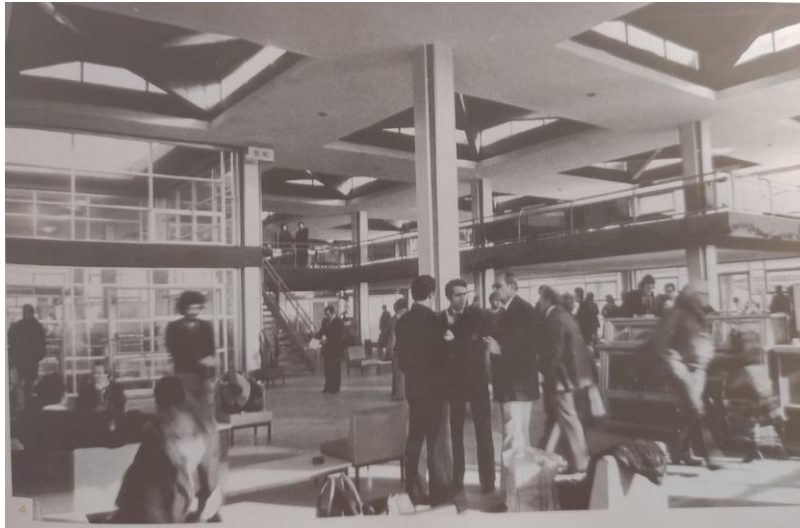
Εικόνα: Σταθμός επιβατών Αεροδρομίου Αλεξανδρούπολης(σημερα κατεδαφισμένος), 1970-1976, σε συνεργασία με τους Πάνο Κουλέρμο και Σπύρο Αμούργη, πηγή: (Τσακόπουλος, 2014, σ. 325)
