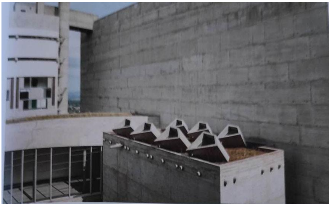
Εικόνα: Τα ακουστικά διαμάντια, φεγγίτες οροφής σχεδιασμένοι από τον Έλληνα Ιάννη Ξενάκη που εργαζόταν στο γραφείο του LeCorbusier για την Tourette, 1953. Πηγή: www.archdaily.com/ad-classics-convent-of-la-tourette-le-corbusier/
