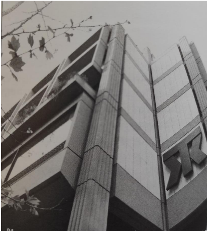
Εικόνα: Δεκαβάλλας, επεξεργασία της όψης στην Τράπεζα Κρήτης, 1978, πηγή: (Φιλιππίδης, Το σκυρόδεμα στον 20ο αιώνα, 1987)
