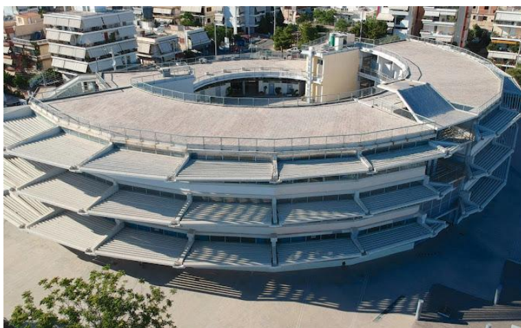
Εικόνα: Εξωτερικές μεταλλικές κατασκευές στο στρογγυλό σχολείο στον Άγιο Δημήτριο 1969. Πηγή: (wikipedia, 2023)
