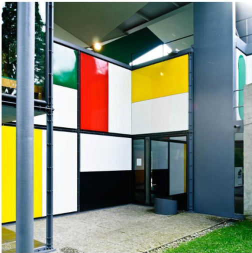
Εικόνα: Άποψη εξωτερική του διώροφου χώρου Centre LeCorbusier/ LeCorbusier Pavillion, Ζυρίχη, Ελβετία. Διακρίνεται ο μεταλλικός σκελετός του κτιρίου και τα μεταλλικά στηρίγματα της οροφής, Πηγη: (Molloy, 2021)
