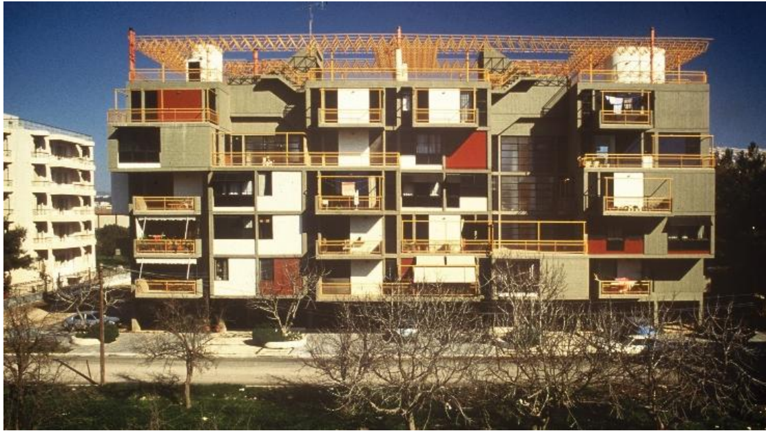
Εικόνα: Πολυκατοικία στο Πολύδροσο Χαλανδρίου, Γραφείο Μπίρη-Μ. Καφρίτσα, 1979-1980, πηγή: (Μπίρης, https://biris-tsiraki-architects.com/ , 2020)
