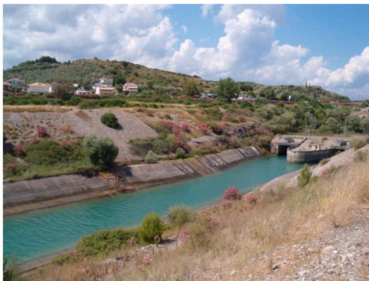
Σχήμα 6.7: Εγκιβωτισμένη κοίτη ποταμού Αχελώου
