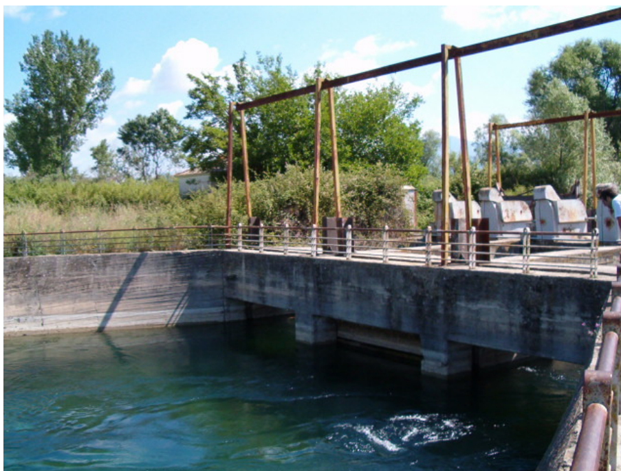
Σχήμα 6.5: Εικόνα του θυροφράγματος Τριχωνίδας–Λυσιμαχείας από την πλευρά της Λυσιμαχείας
