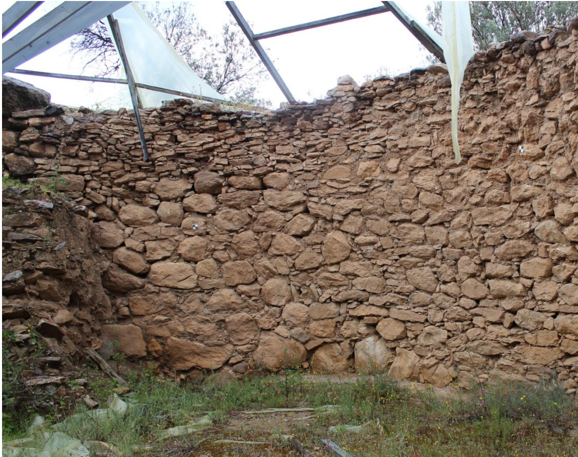
Τα διαφορετικά συστήματα τοιχοδομίας στο δυτικό ανώτερο τοίχωμα του θαλάμου.
