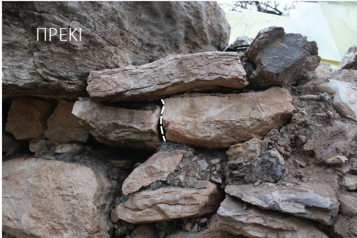
Θραυσμένος λίθος στην βορειοανατολική έδραση του ανωφλιού.
