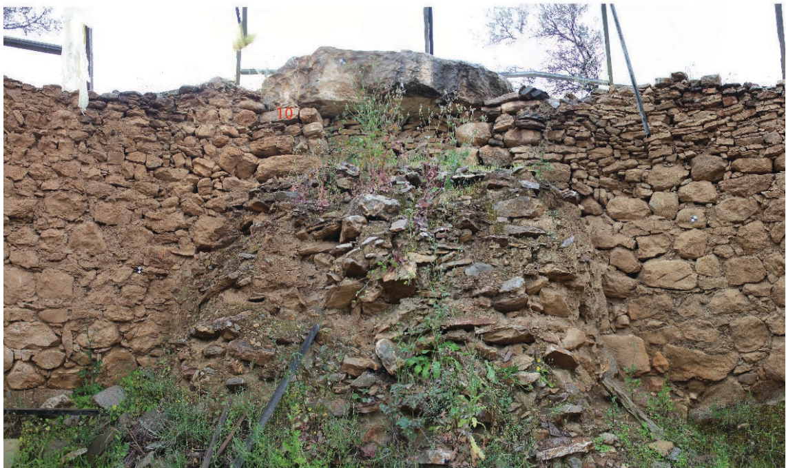
Εσωτερική είσοδος στο στόμιο (πάνω: κατά την ανασκαφή ,πηγή: αρχείο κας Κονσολάκη, κάτω: υφιστάμενη κατάσταση).
