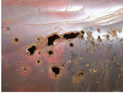
Εικ.2.16: Δείγμα υπόγειας διάβρωσης σε υπόγειο σωλήνα αλουμινίου
