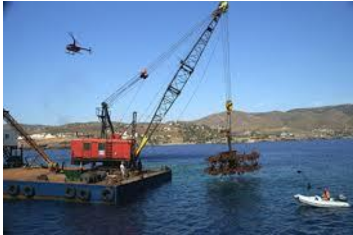
Εικόνα 3.10: Η ανέλκυση ενός εκ των δύο τροχών του ατμόπλοιου Πατρίς». (πηγή: http://www.ketepo.gr ).
