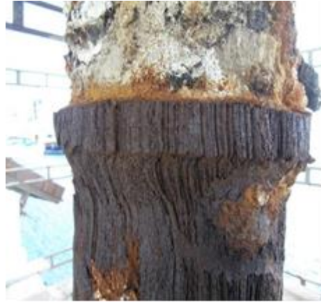
Εικ 3.17: Συμπαγής κεντρικός άξονας του τροχού.
