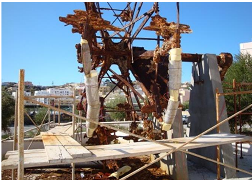
Εικόνα 3.24: Εφαρμογή μεθόδου αποχλωρίωσης στον τροχό.
