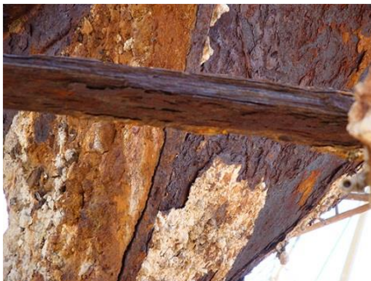
Εικόνα 3.12: Διάβρωση του τμήματος τροχού.
