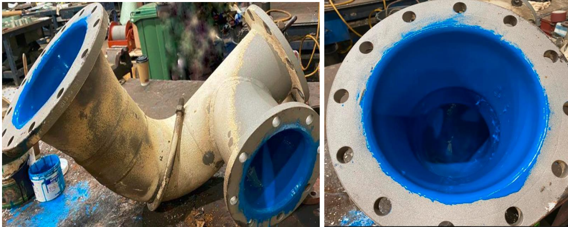
Σχήμα 5.15 Φωτογραφίες σωληνώσεων και επιστομίου πριν και μετά το δεξαμενισμό δεξαμενοπλοίου δεκαετίας – Ναυπηγεία Νεωρίου, Σύρος 2023
