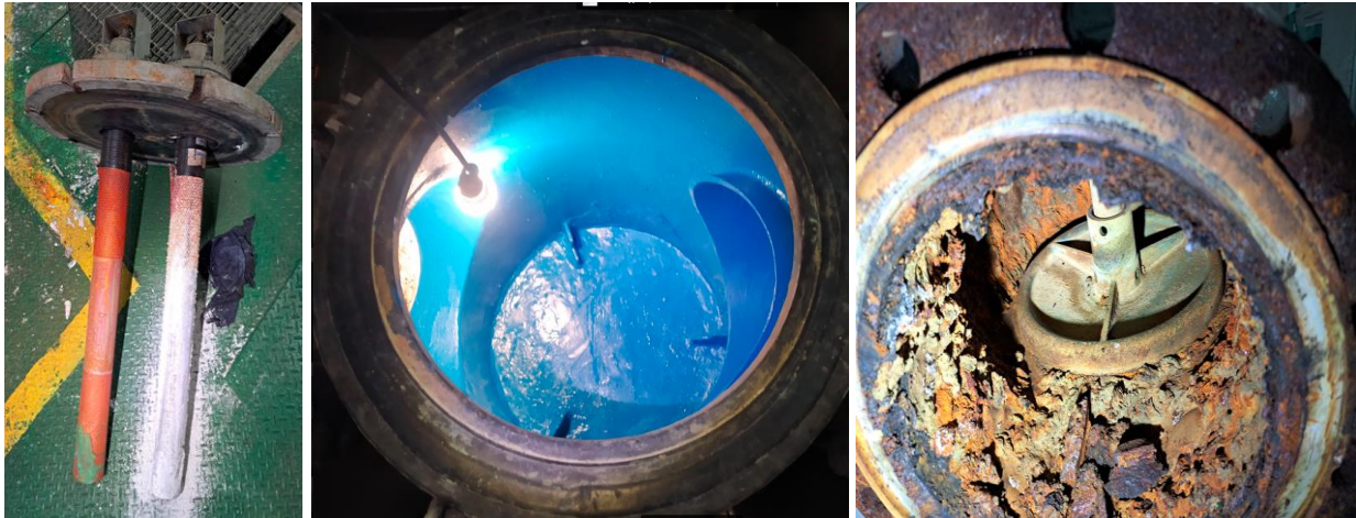
Σχήμα 5.14 Φωτογραφίες φίλτρων, ανοδίων και επιστόμιου σωλήνωσης αναρροφήσεων θαλάσσης πριν και μετά το δεξαμενισμό δεξαμενοπλοίου δεκαετίας – Ναυπηγεία Νεωρίου, Σύρος 2023
