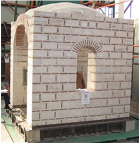
Σχήμα 2.19. Οριζόντιες ρωγμές στην ανατολική όψη
