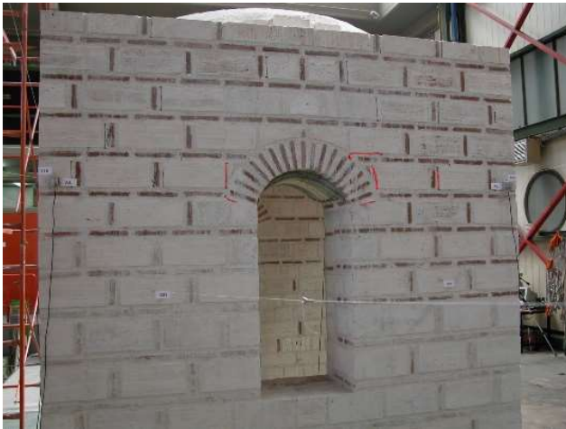
Σχήμα 4.55. Εικόνα πειράματος. Ρωγμές στο τόξο του παραθύρου & στην τοιχοποιία.
