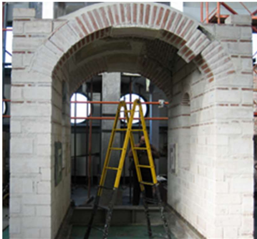
Σχήμα 2.21. Αποκόλληση σταυροθολίου στη νότια
