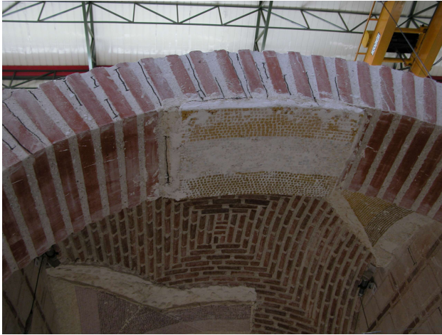
Σχήμα 4.61. Εικόνα πειράματος. Ρωγμές στο κέντρο του τόξου.
