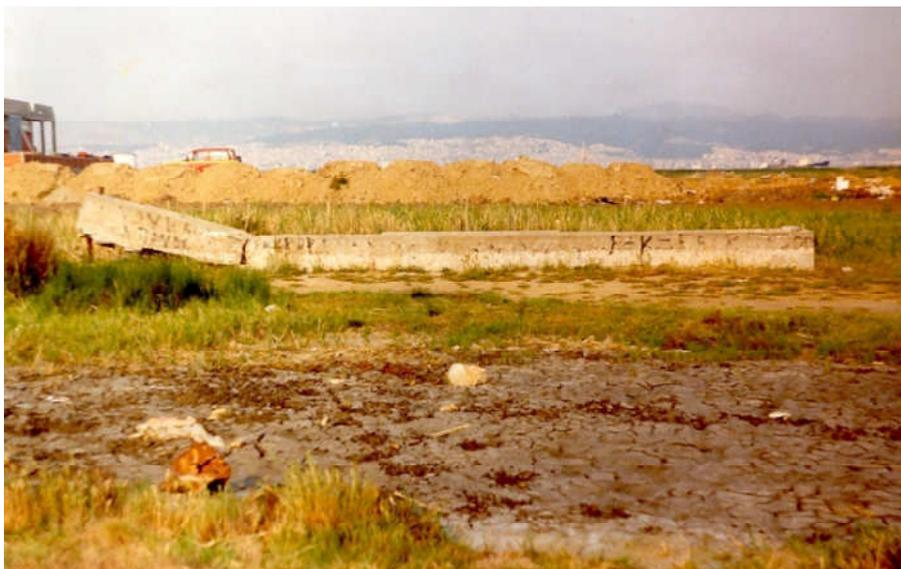
**Εικόνα 1.1 Η ανύψωση τμήματος ποτίστρας και η αποκοπή του από το υπόλοιπο τμήμα λόγω των εδαφικών υποχωρήσεων στην περιοχή Καλοχωρίου Θεσσαλονίκης. Πόρος**
