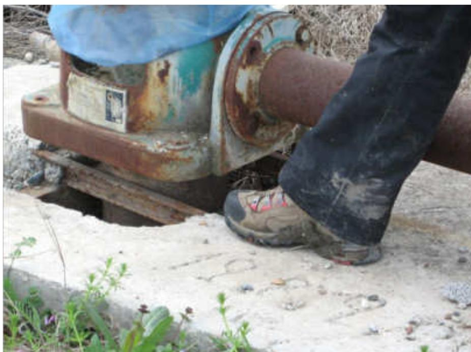
**Φωτογραφία Σωλήνας γεώτρησης που έχει ανυψωθεί λόγω διαφορετικής παραμόρφωσης με το βάθος**
