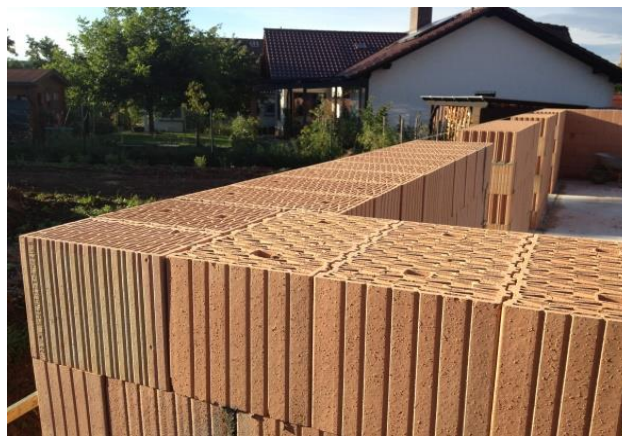
Εικόνα 5.68 Θερμομονωτικά τούβλα Poroton ορθομπλοκ - σενάριο 4
