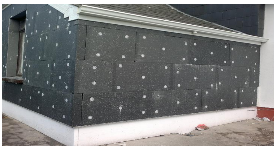
Εικόνα 3.46 Κάλυψη κελύφους κτιρίου με EPS για θερμική προστασία
