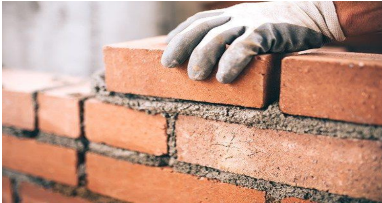
Εικόνα 3.23 Δομική οπτοπλινθοδομή με προσθήκη τσιμεντοκονιάματος
