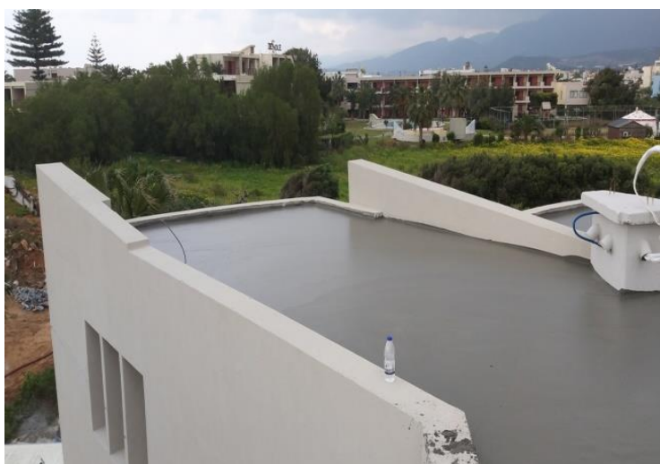
Εικόνα 3.43 Επίστρωση οροφής με ελαφρομεπτόν - αύξηση θερμικής προστασίας
