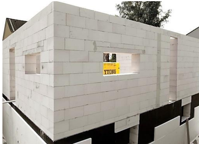
Εικόνα 5.80 Δομή AAC blocks - σενάριο 5
