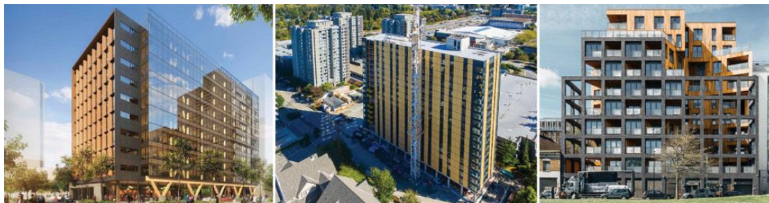
Εικόνα 3.10 Πολυόροφα κτίρια κατασκευασμένα από ξύλο
