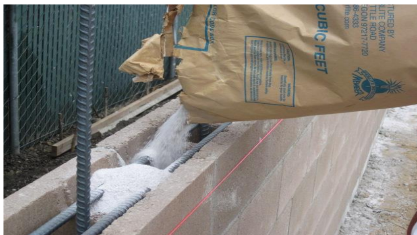
Εικόνα 3.61 Χρήση διογκωμένου περλίτη ως πλήρωση σε τοιχοποιία
