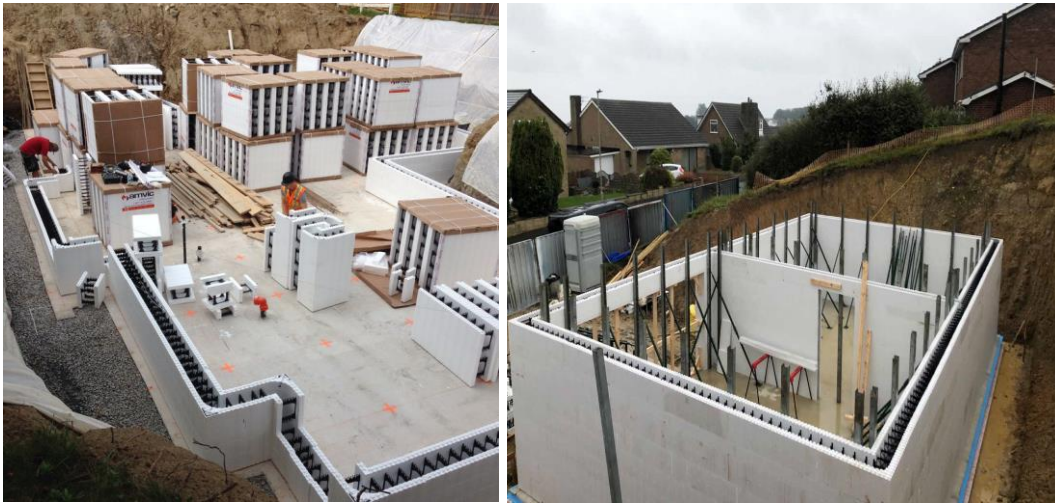
Εικόνα 3.36 Κατασκευή κελύφους κτιρίου από ICF's
