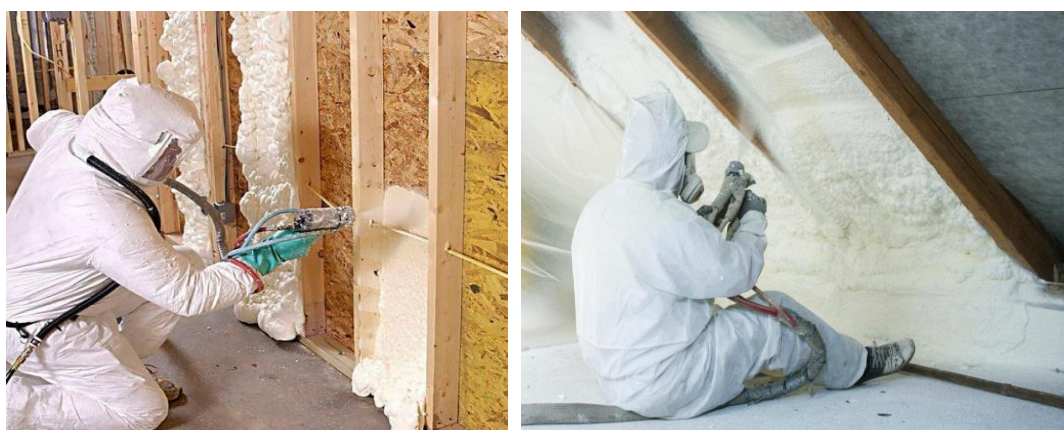
Εικόνα 3.48 Αφρός πολυουρεθάνης, ευρείας χρήσης θερμομονωτικό υλικό
