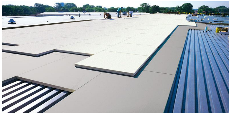
Εικόνα 3.64 Τοποθέτηση πλακών Polyiso σε οροφή για θερμομόνωση
