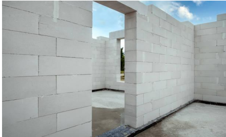
Εικόνα 3.27 Εξωτερικές και εσωτερικές τοιχοποιίες από AAC blocks
