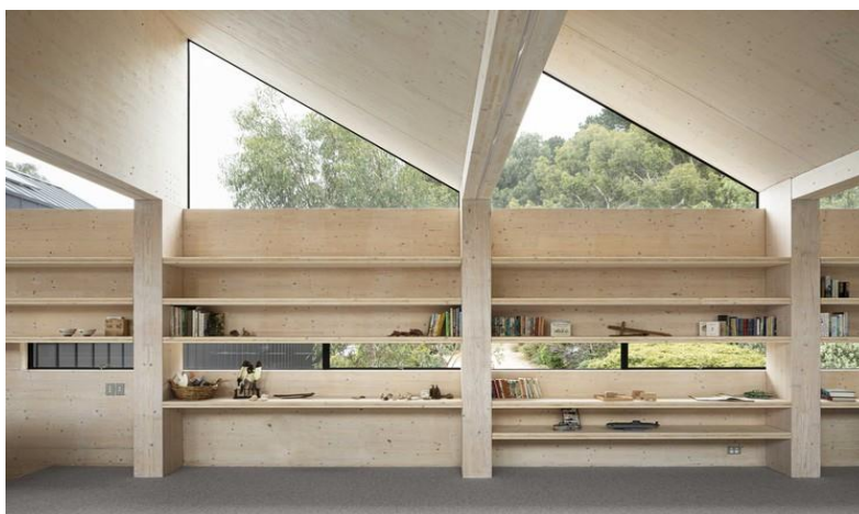
Εικόνα 3.15 Τοιχοποιία και στέγη κτιρίου από CLT
