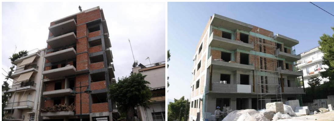
Εικόνα 3.78 Οικοδομικές κατασκευές - συμβατική δόμηση , Ελλάδα
