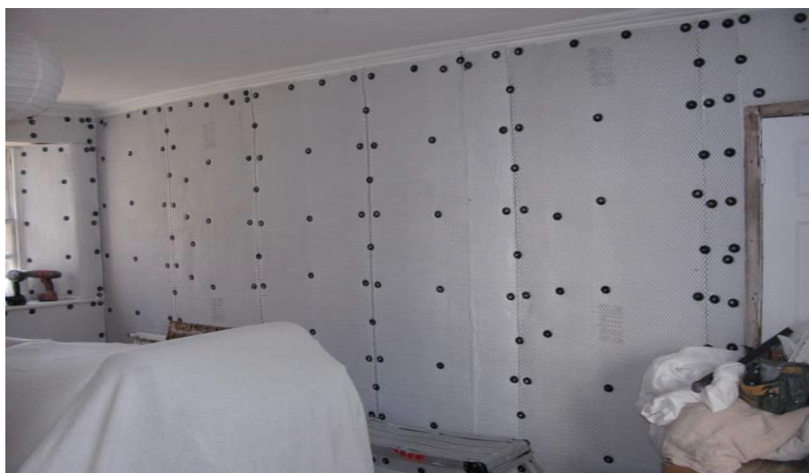
Εικόνα 3.67 Στρώμα aerogel για θερμομόνωση τοίχου κτιρίου
