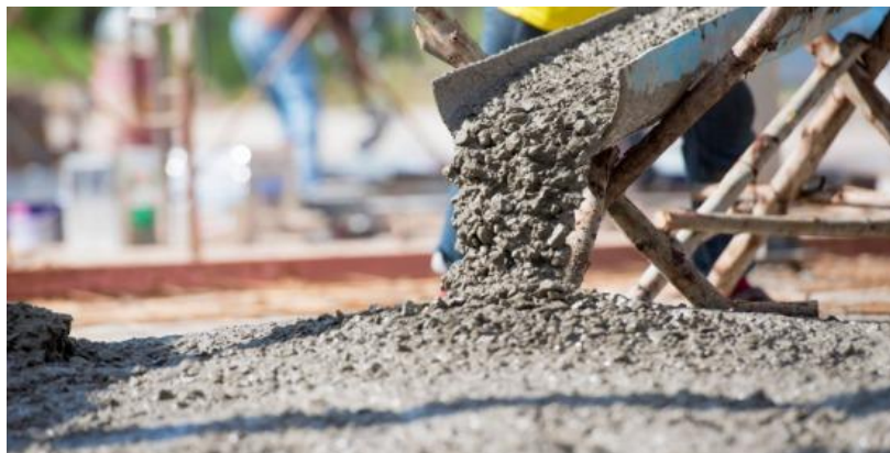
Εικόνα 3.28 Απλό χυτό σκυρόδεμα σε κατασκευή
