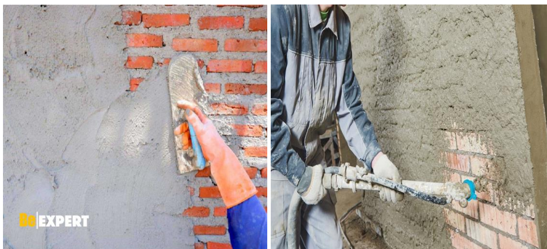
Εικόνα 3.37 Τοποθέτηση σοβά-επιχρίσματος ως τελική στρώση σε τοιχοποιία εσωτερικά & εξωτερικά
