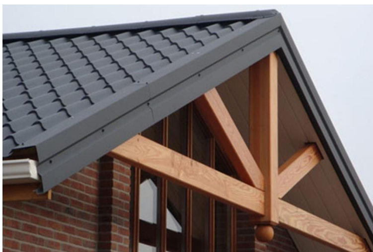
Εικόνα 3.42 Πάνελ στέγης-οροφής πολυουρεθάνης
