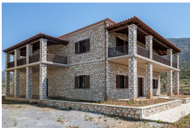
Εικόνα 3.6 Επένδυση κατοικίας με σχιστόλιθο
