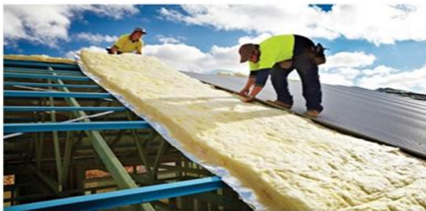
Εικόνα 3.51 Επίστρωση στέγης κτιριακής κατασκευής με υαλοβάμβακα
