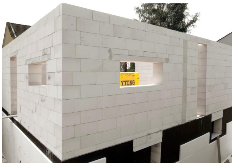
Εικόνα 3.26 Κτιριακό κέλυφος απο AAC blocks
