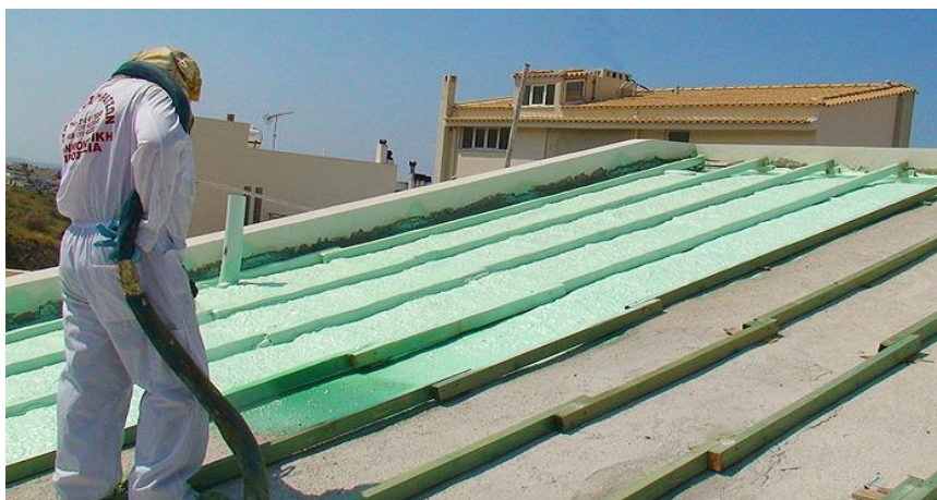
Εικόνα 3.49 Εφαρμογή μόνωσης PUR σε οροφή
