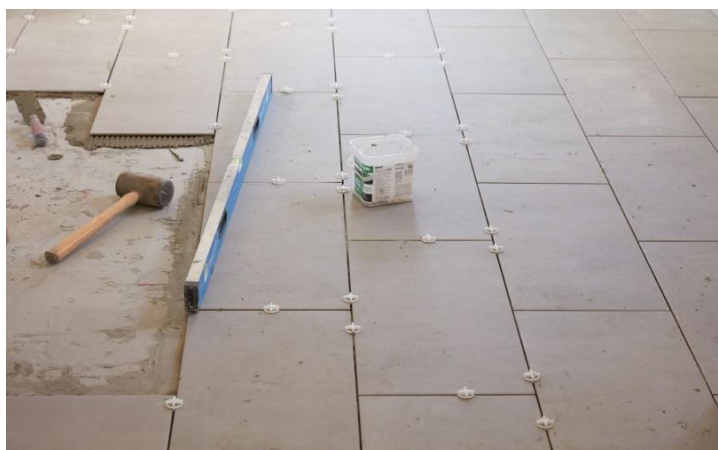
Εικόνα 3.38 Κεραμικά πλακίδια δαπέδου με κονίαμα-κόλλα για τοποθέτηση
