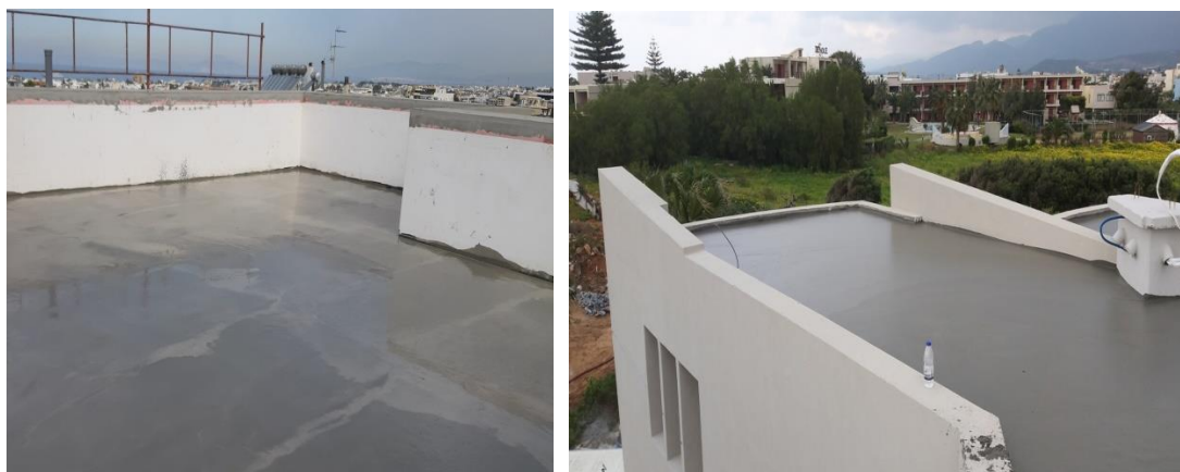
Εικόνα 3.33 Οροφές απο ελαφροσκυρόδεμα
