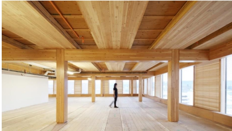
Εικόνα 3.17 Cross Laminated Timber , το "σκυρόδεμα" του μέλλοντος , ArchDaily
