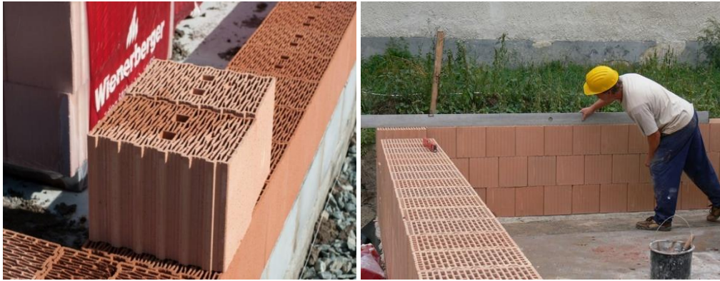
Εικόνα 3.25 Κατασκευή τοιχοποιίας από Poroton blocks
