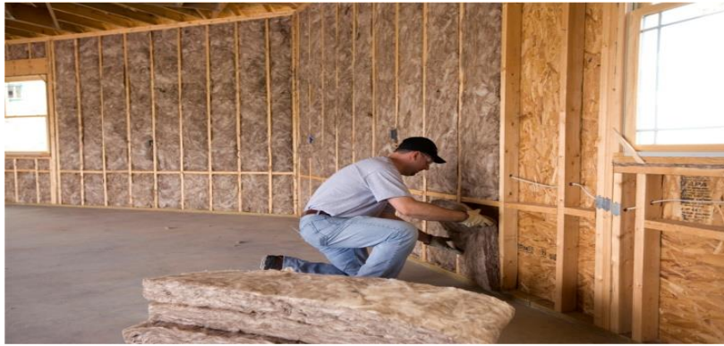
Εικόνα 3.53 Εφαρμογή πετροβάμβακα εσωτερικά σε τοιχοποιία πληρώσεως
