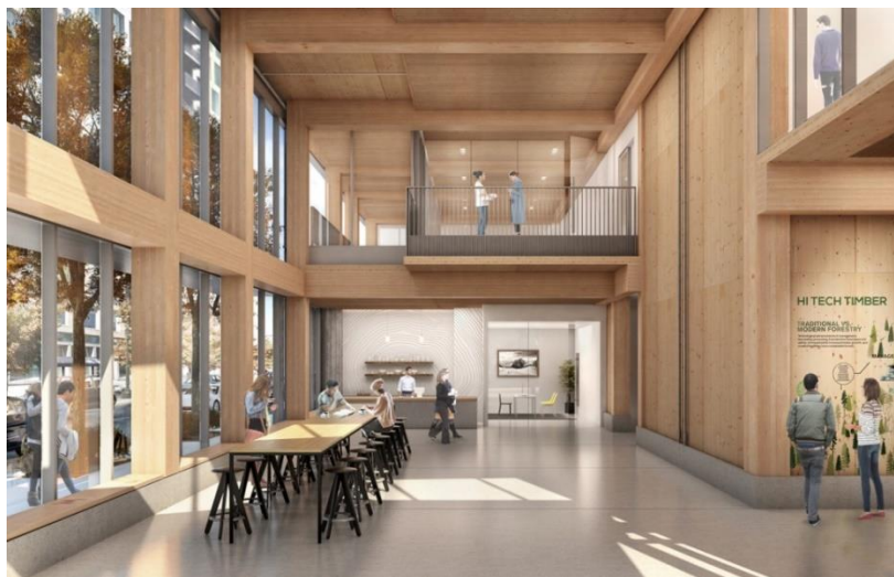
Εικόνα 3.19 Κέλυφος μεγάλου κτιρίου από CLT
