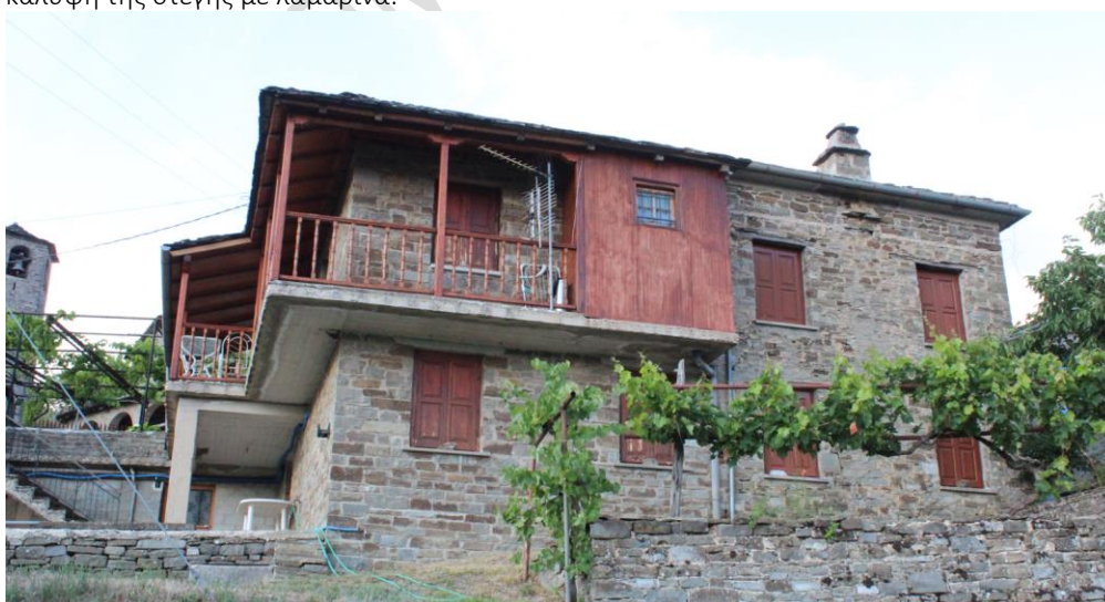
Εικ.46. Επέμβαση σε υφιστάμενο κτίσμα στους Φραγκάδες, οι οποίες βλάπτουν και το δομικό σύστημα του κτηρίου, πέρα από την εικόνα του. Προσθήκες από οπλισμένο σκυρόδεμα, εξώστες γωνιακοί, μεγαλύτεροι από το επιτρεπόμενο όριο, κλείσιμο όγκου στην όψη για τη δημιουργία WC.
