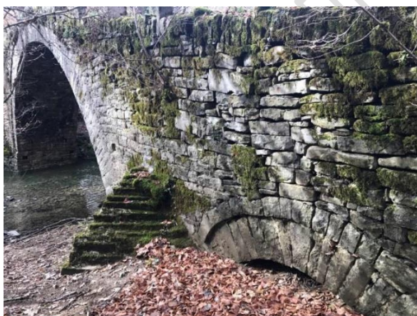
Εικ.56. Η συσσώρευση φερτών υλικών έχει κλείσει την πλευρική καμάρα αυτού του γεφυριού στο ρέμα του Ντόμπρου. Εάν δεν καθαριστεί, όταν έρθει ορμητικά το νερό μπορεί να προκληθούν δομικές βλάβες στο γεφύρι. Πηγή: Αρχείο Μ.Μπαλοδήμου
