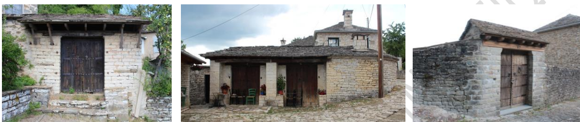
Εικ.21&22&23. Αυλόθυρες στο Δίλοφο, τη Βίτσα και τους Νεγάδες.
