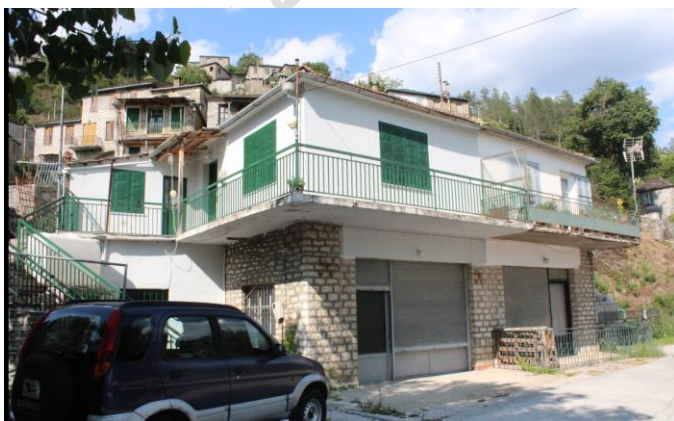
Εικ.48. Κήφοι: τυπική κατασκευή των δεκαετιών μετά τον Β' Π.Π. και πριν τα διατάγματα προστασίας, που δεν ακολουθεί τα παραδοσιακά πρότυπα: κατασκευή από οπλισμένο σκυρόδεμα, περιμετρικοί εξώστες, κάλυψη στέγης με κεραμίδια, αναλογίες ανοιγμάτων, εξωτερικά κλιμακοστάσια.
