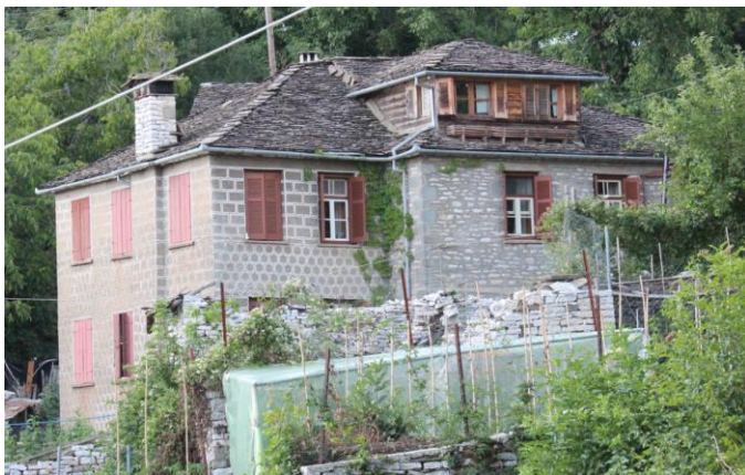
Εικ.47. Κατοικία στο Καπέσοβο με σημαντικές αλλοιώσεις της εικόνας και του δομικού συστήματός της.
