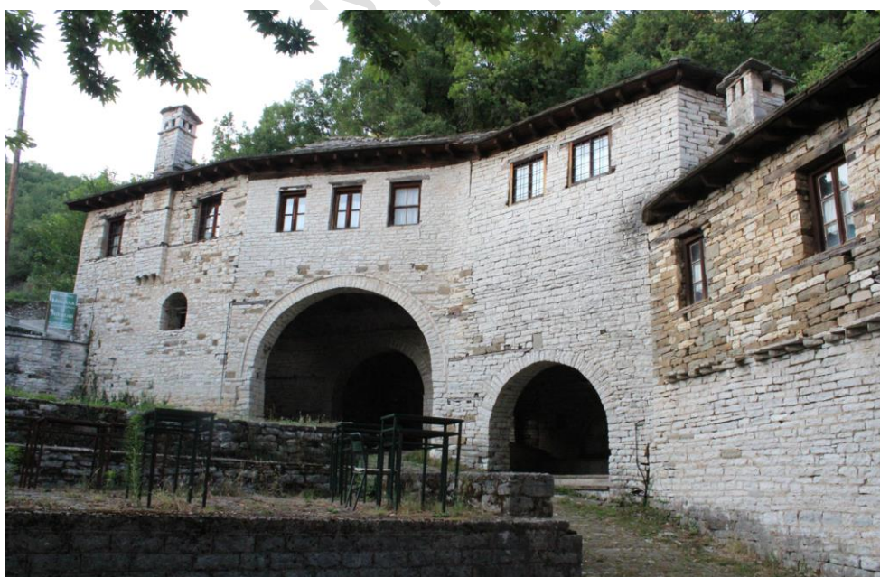
Εικ.35. Κτήριο που ανήκει στην κοινότητα Κουκουλίου, που έχει λειτουργήσει στα χρόνια της ζωής του ως κοινοτικό γραφείο-ιατρείο και ως ξενώνας και κατοικία του δασκάλου.
