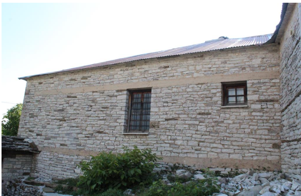
Εικ.45. Επεμβάσεις σε υφιστάμενο κτίσμα στο Βραδέτο, με εμφανή διαζώματα από οπλισμένο σκυρόδεμα και κάλυψη της στέγης με λαμαρίνα.
