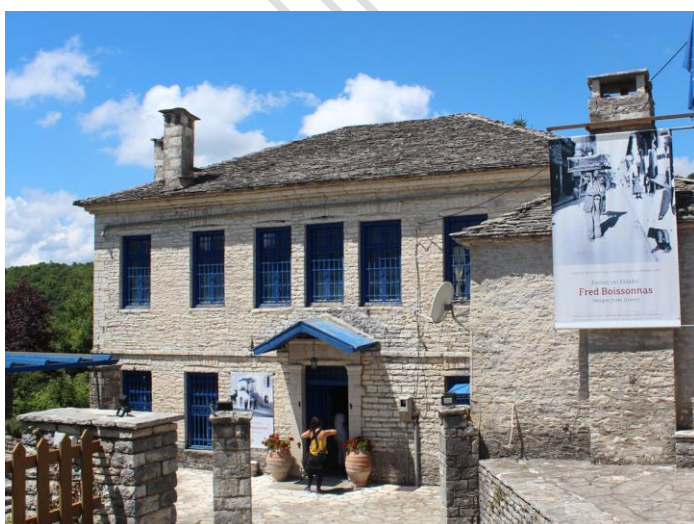
Εικ.30. Αποκατάσταση της στέγης στην Πασχάλειο Σχολή στο Καπέσοβο.
