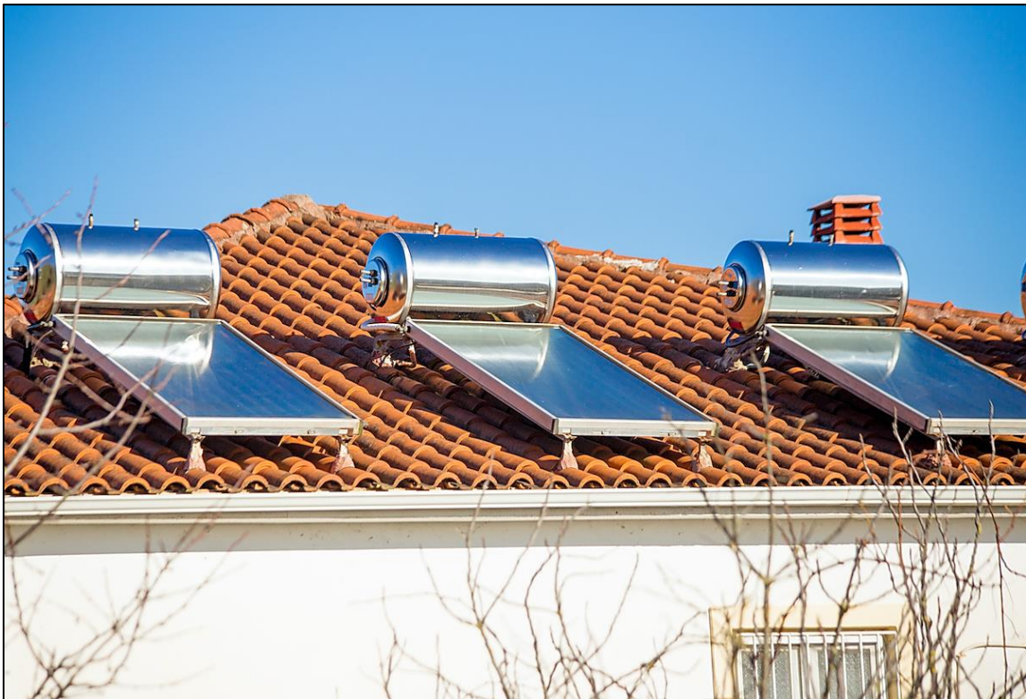
Εικόνα 5: Επίπεδοι ηλιακοί συλλέκτες σε οροφή οικίας [16]
