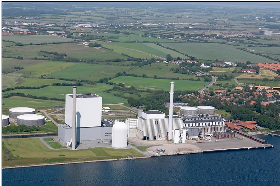
Εικόνα 9: Σταθμός ηλεκτροπαραγωγής με χρήση βιομάζας [21]
