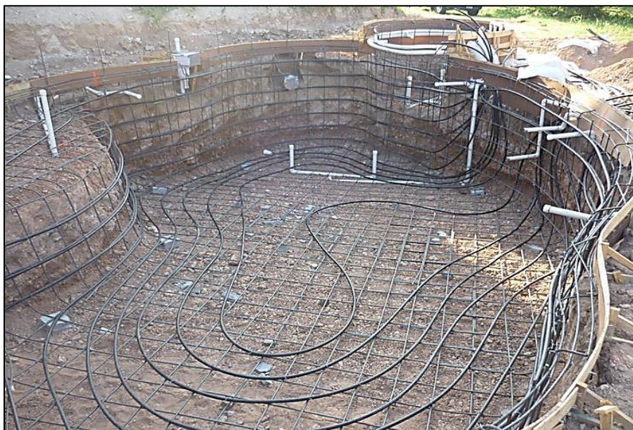
Εικόνα 10: Σύστημα εκμετάλλευσης γεωθερμίας [22]
