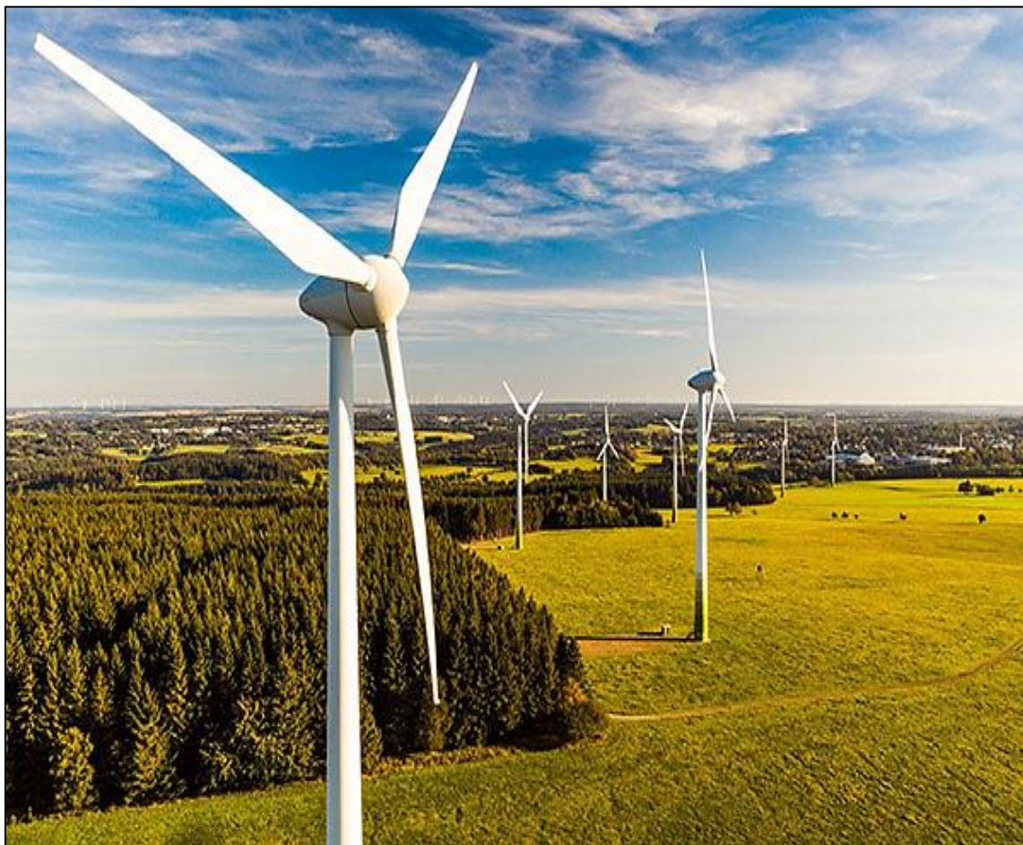
Εικόνα 6: Ανεμογεννήτρια οριζοντίου άξονα με τρία πτερύγια [17]
