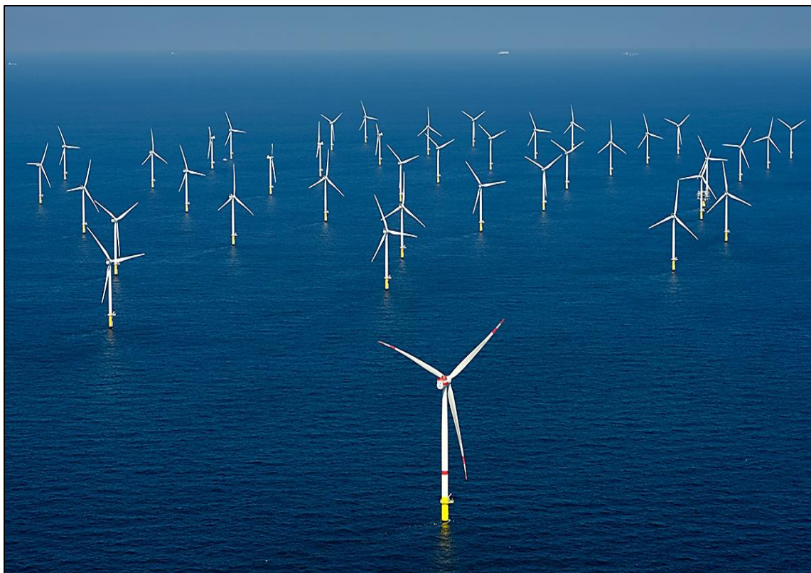
Εικόνα 7: Υπεράκτιο αιολικό πάρκο [18]
