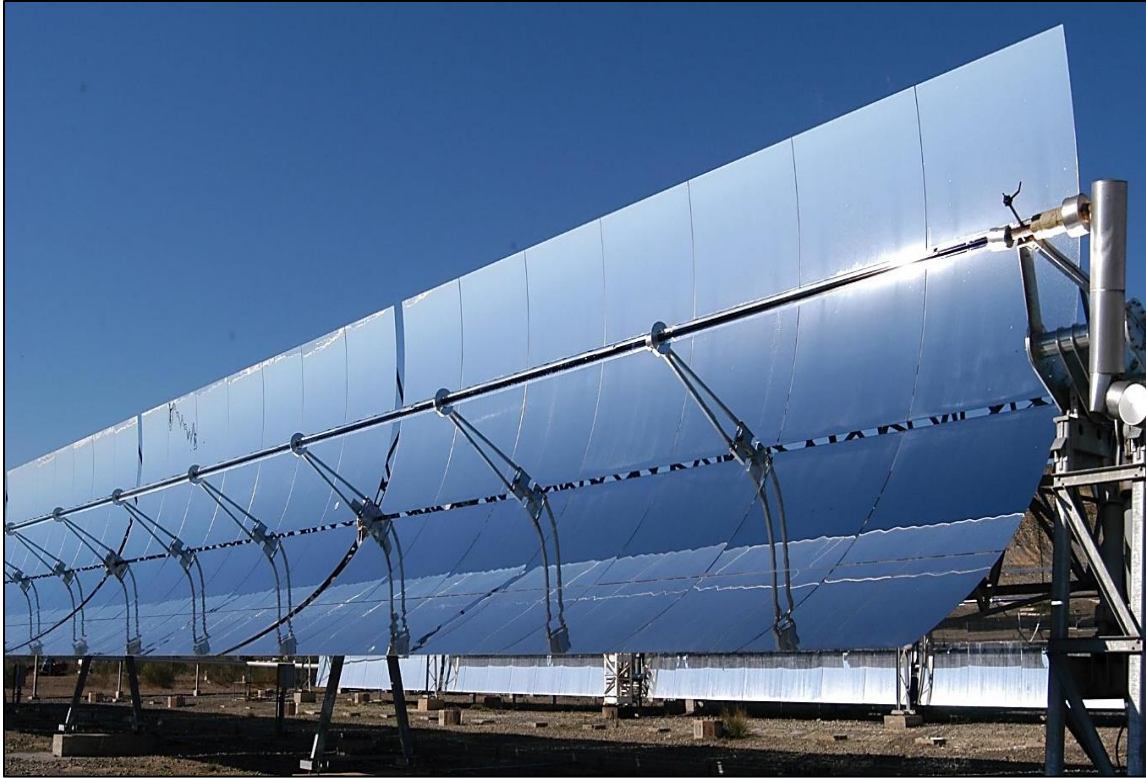
Εικόνα 4: Συστοιχία παραβολικών συγκεντρωτικών ηλιακών συλλεκτών [15]
