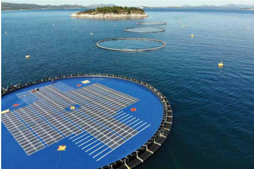
Εικόνα 2.11 Εφαρμογή πλωτών Φ/Β στη θάλασσα στα ανοικτά της δυτικής ακτής της Νορβηγίας [24]
