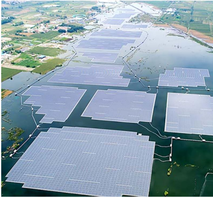
Εικόνα 2.9 Εφαρμογή πλωτών Φ/Β σε υδάτινα σώματα παλιών λατομείων και μεταλλουργείων στην Κίνα ισχύος 70 MWp [33]
