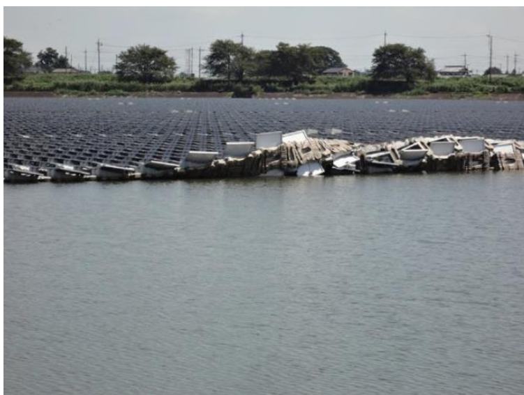
Εικόνα 2.4 Παράδειγμα ανατροπής πλωτής πλατφόρμας σε πλωτό Φ/Β πάρκο στην Ιαπωνία [10]
