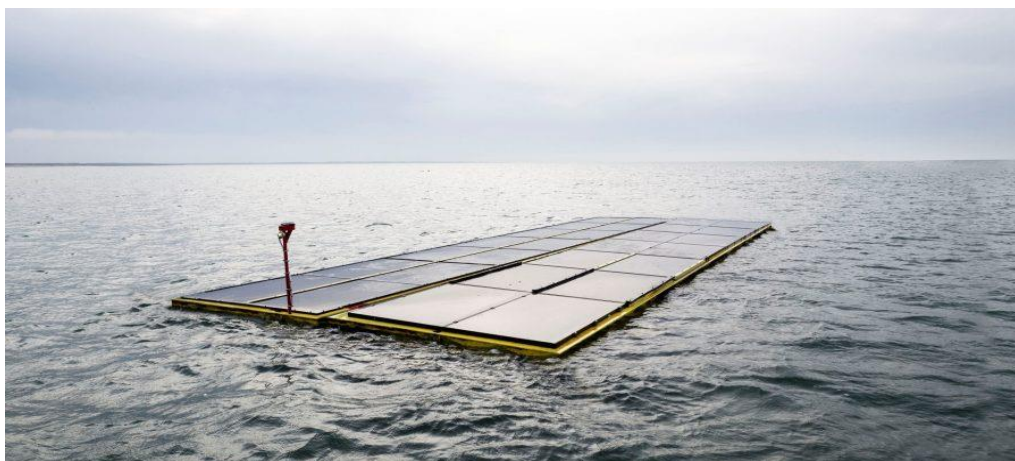
Εικόνα 2.19 Υπεράκτια εγκατάσταση της Oceans of Energy [39]
