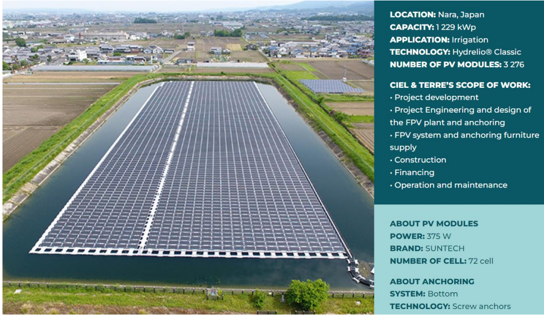
Εικόνα 2.7 Εφαρμογή πλωτών Φ/Β σε λίμνη άρδευσης στην Ιαπωνία ισχύος 1.23 MWp [32]
