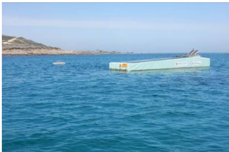
Εικόνα 2.14 Πλωτή πλατφόρμα από διογκωμένο πολυστυρένιο [36]
