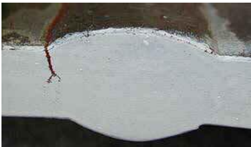
Σχήμα 1.19 Διάβρωση από μηχανική καταπόνηση
