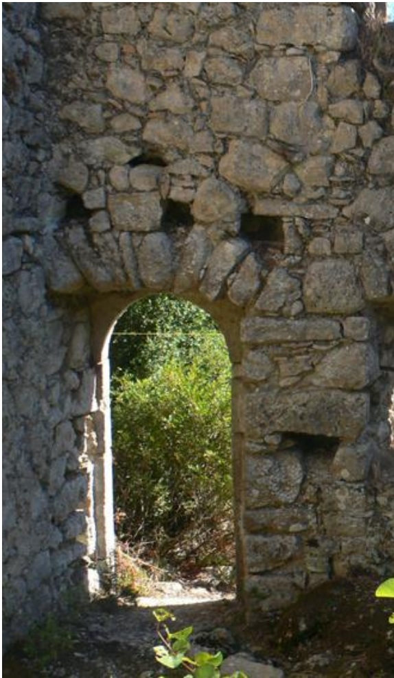
Εικόνα 138 - Κατασκευή τοξωτού ανοίγματος στην συνάντηση μακρύ και εγκάρσιου τοίχου
