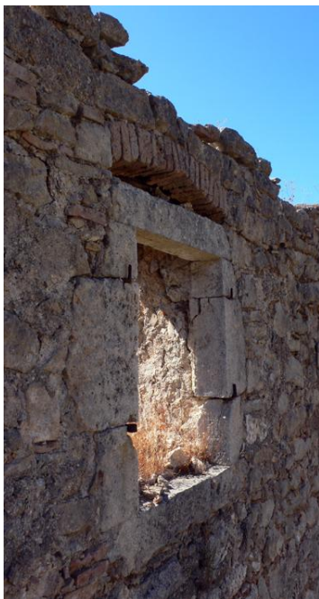
Εικόνα 103 - Τούβλινο ανακουφιστικό τόξο σε παράθυρο
