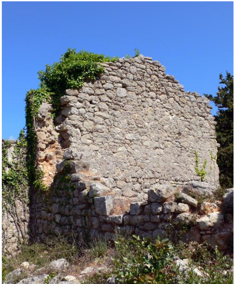
Εικόνα 111 - Ο δυτικός εγκάρσιος τοίχος μερικώς αποκολλημένος από τους μακρούς τοίχους
