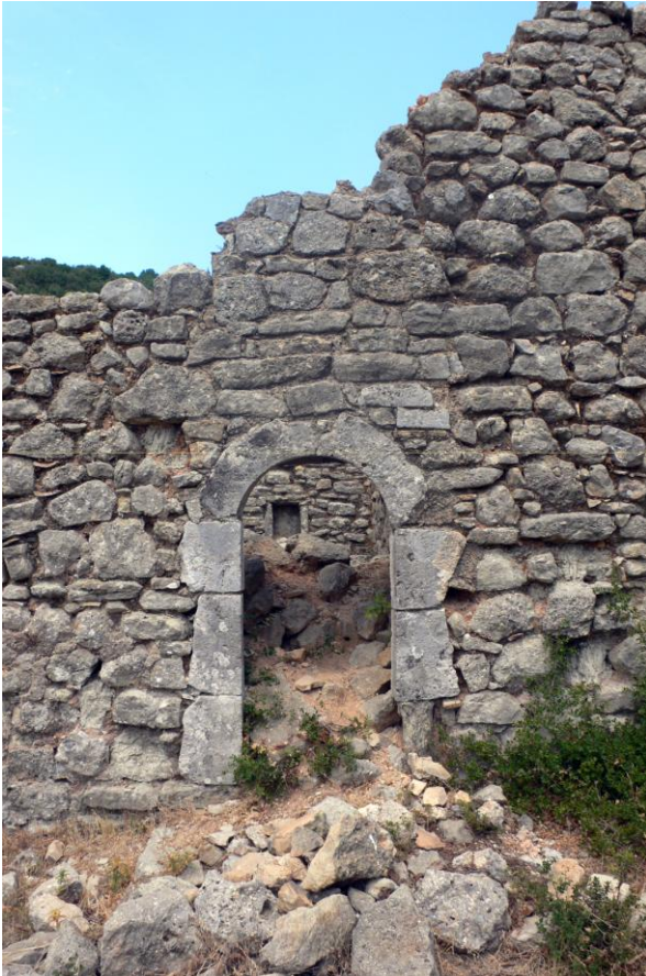
Εικόνα 116 - Αλλαγή τοιχοποιίας λόγω της επισκευής
