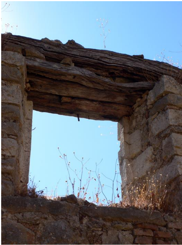
Εικόνα 101 - Παράθυρο με ξύλινο πρέκι
