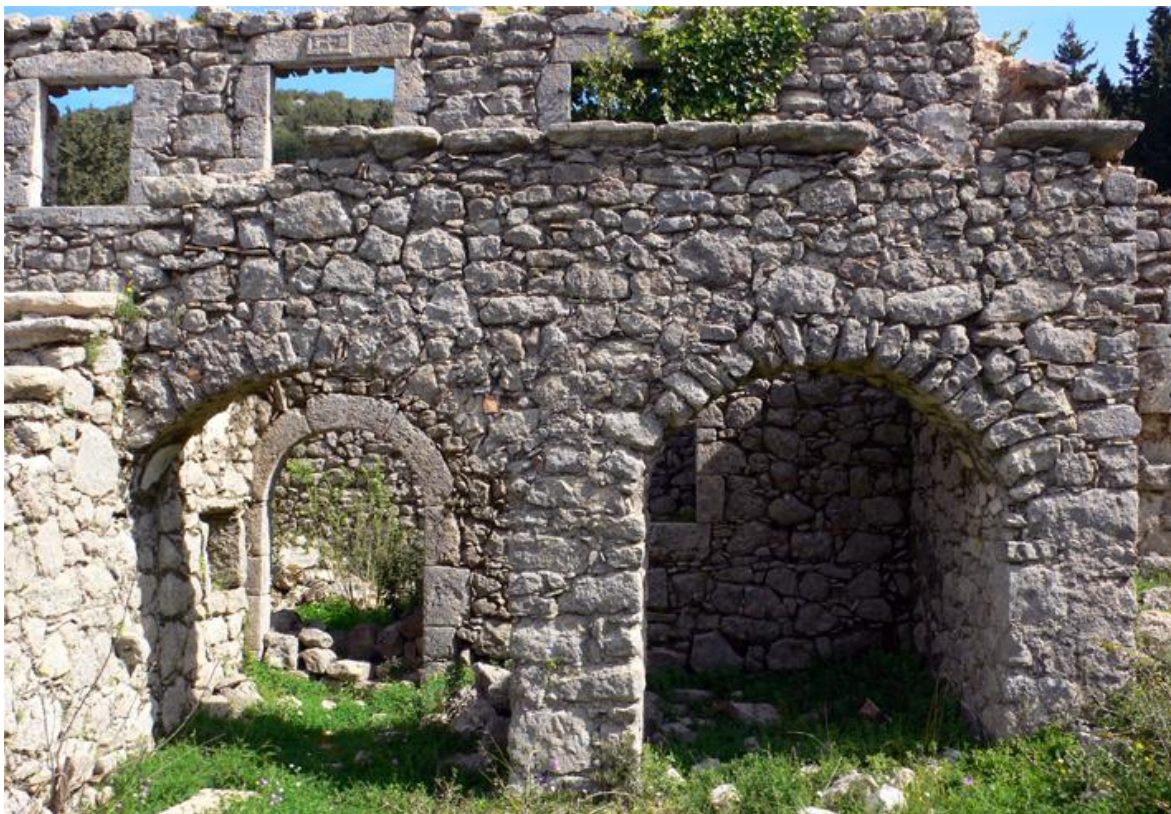
Εικόνα 145 - Τα διπλά λίθινα τόξα του εξώστη
