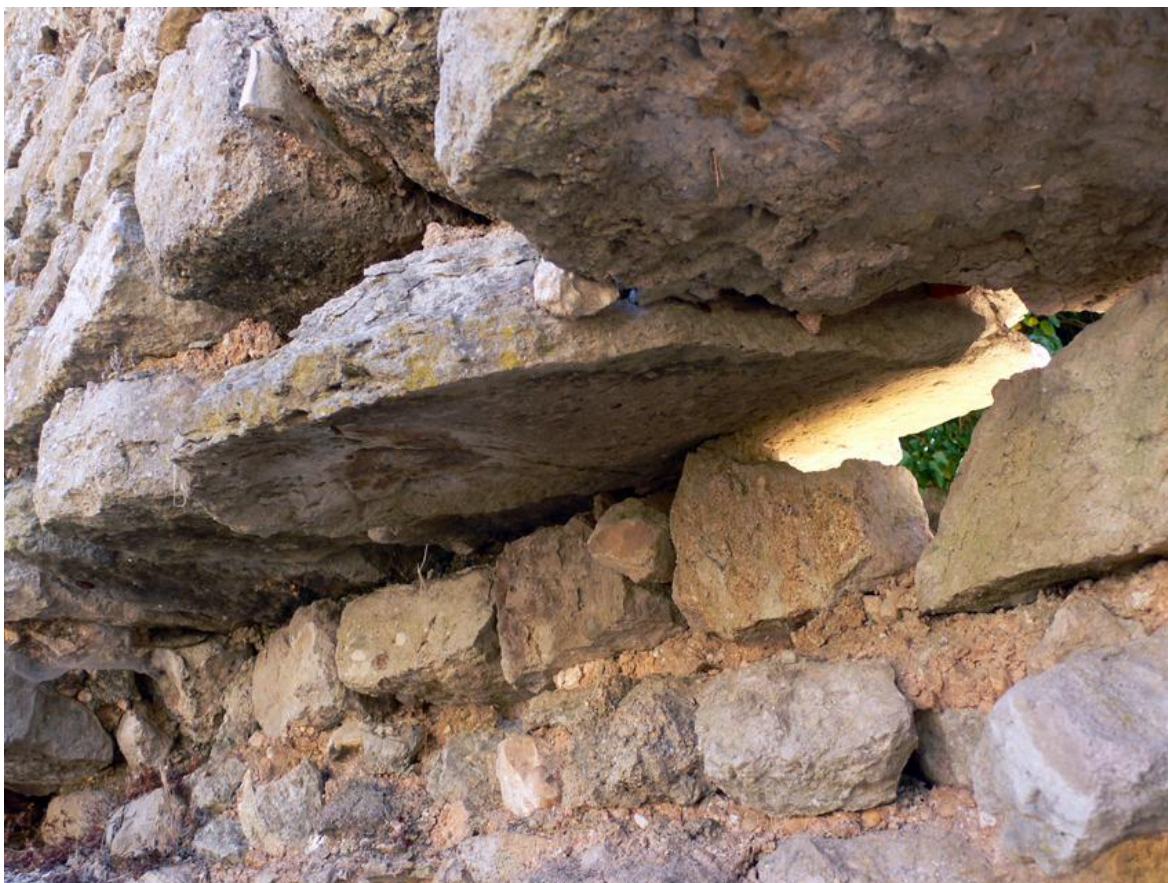
Εικόνα 181 - Οι περαστοί πεπλατυσμένοι λίθοι που συγκρατούν με επιτυχία την τοιχοποιία
