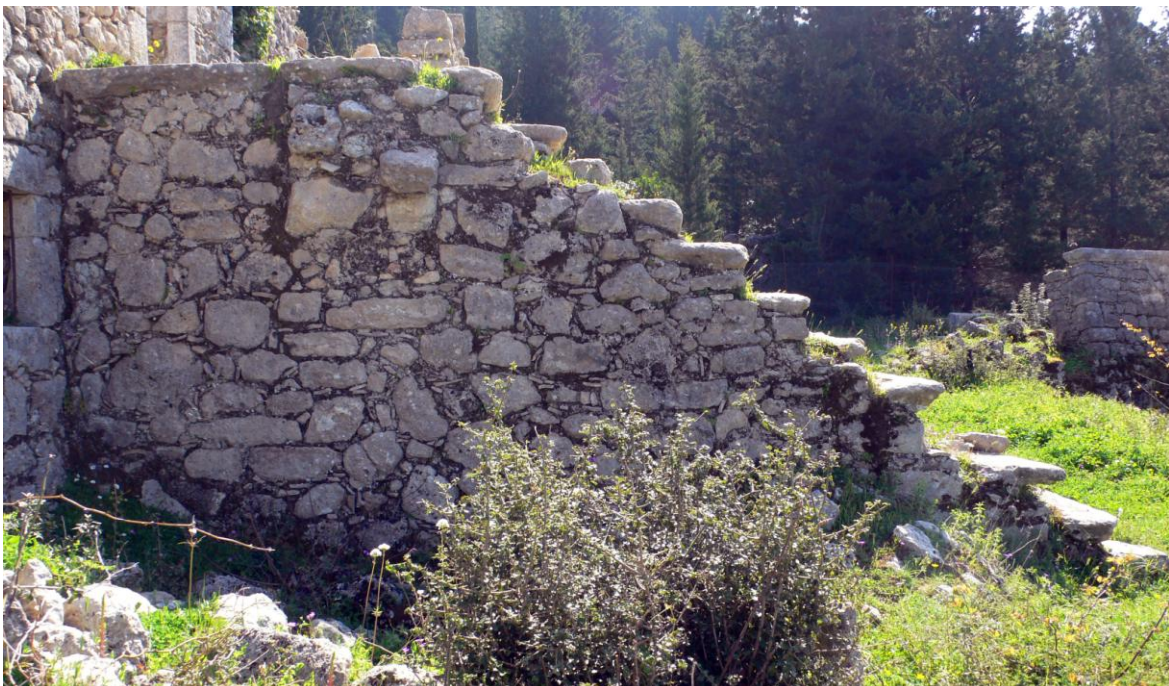
Εικόνα 64 - Η βαριά λίθινη σκάλα της πτέρυγας των κελιών στον Άγιο Γεώργιο στους Σκάρους, διακρίνεται η κατεστραμμένη γένεση των λίθινων τόξων που σχημάτιζαν τον εξώστη.
