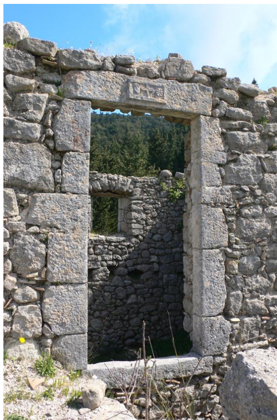
Εικόνα 188 - Θύρα εισόδου στον όροφο
