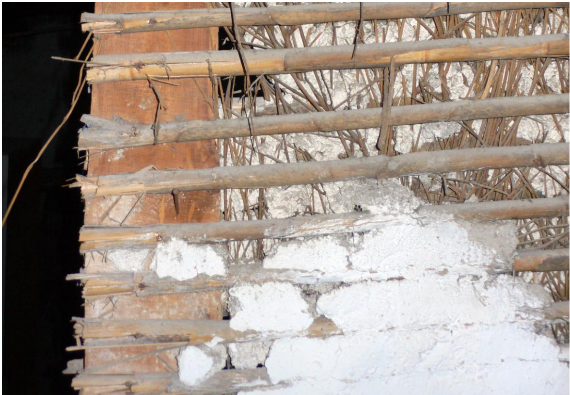
Εικόνα 29 - Λεπτομέρεια του προηνούμενου τοίχου
