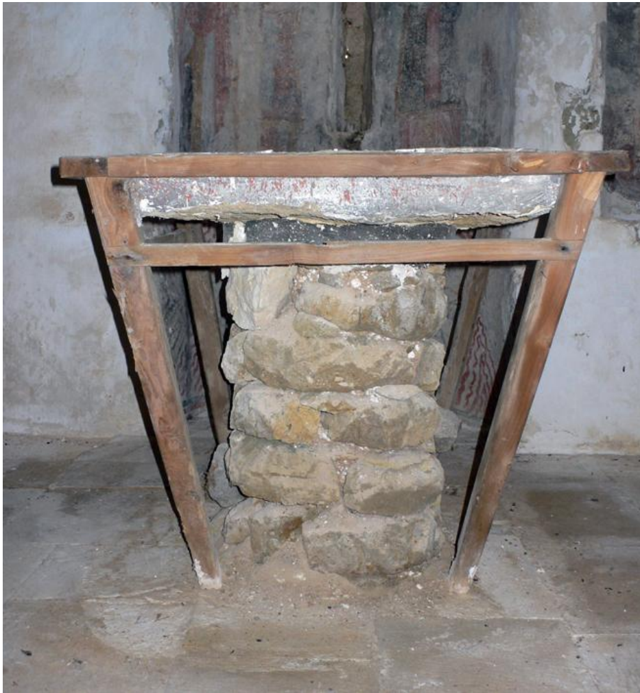
Εικόνα 151 - Η κτιστή λίθινη Τράπεζα και ο ξύλινος ενισχυτικός νάρθηκας
