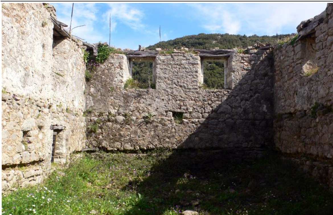
Εικόνα 186 - Εσωτερική εικόνα κτηρίου Β
