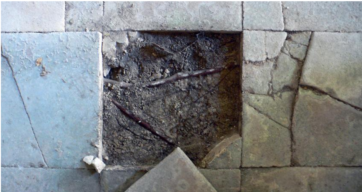
Εικόνα 152 - Ανασηκωμένο πλακίδιο και αποκάλυψη της ανάπτυξης ριζικού συστήματος στο χωμάτινο υπόβαθρο
