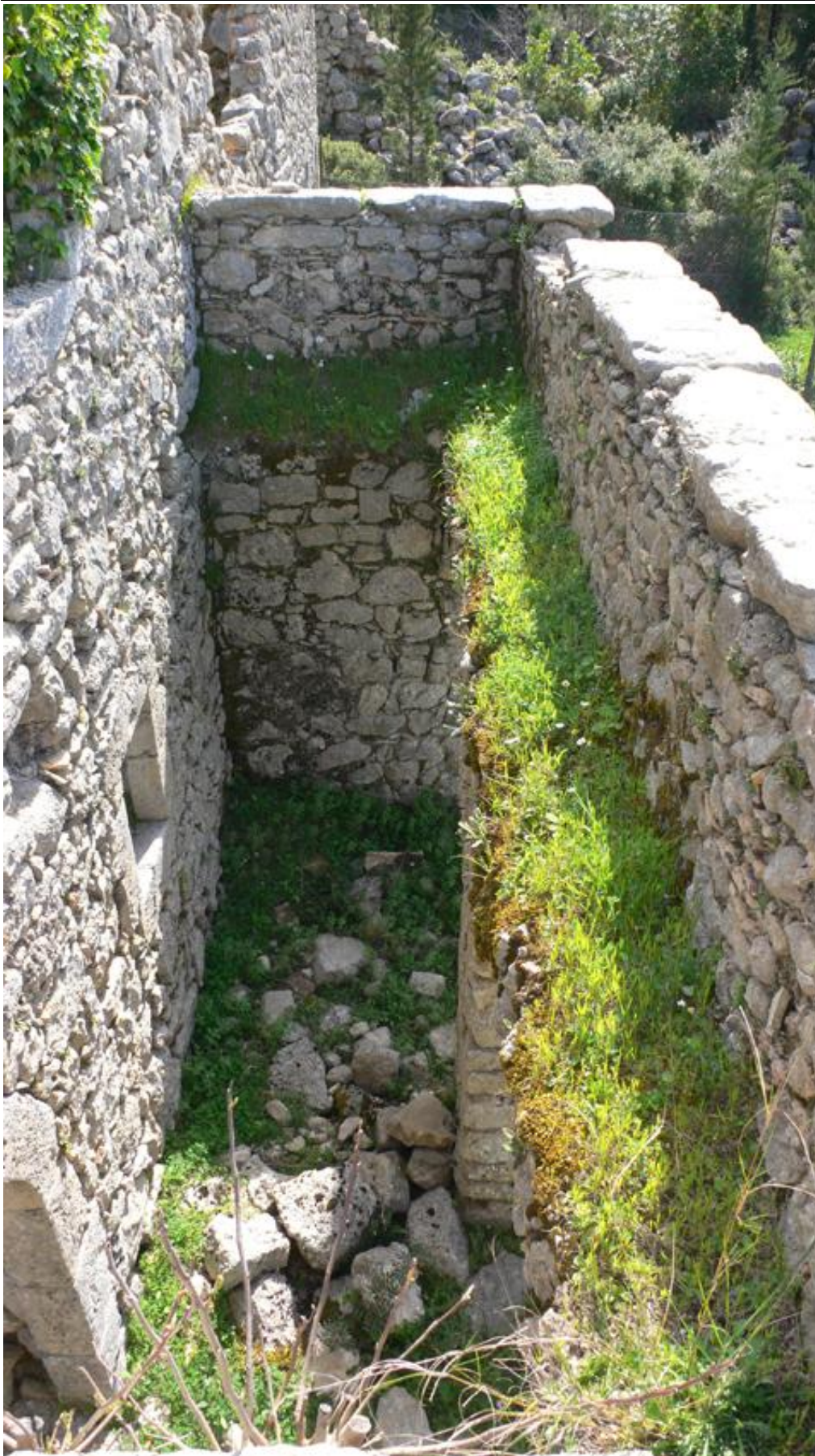
Εικόνα 189 - Αποψη του λίθινου εξώστη με την πατούρα στήριξης των δοκών
