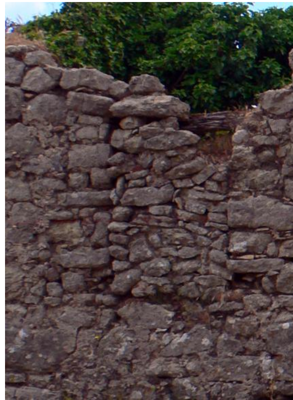
Εικόνα 149 - Φραγμένο άνοιγμα στην ανατολική όψη του κτηρίου Α
