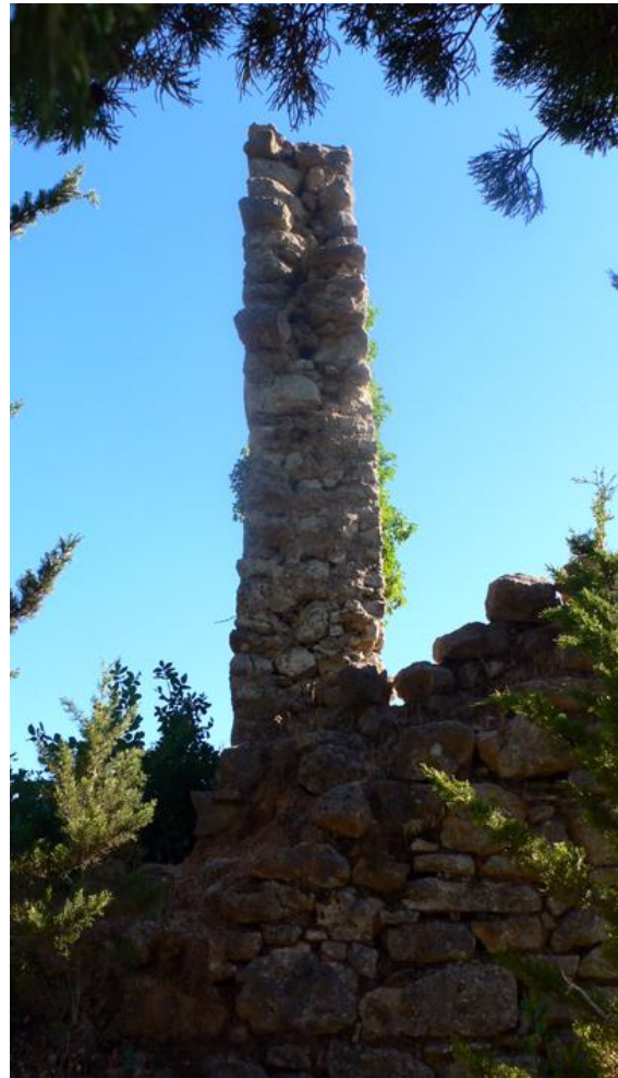
Εικόνα 139 - Ο δυτικός εγκάρσιος τοίχος του συγκροτήματος των κελιών στέκει ακόμα όρθιος σε πρόβολο αποκολλημένος από τους διαμήκεις
