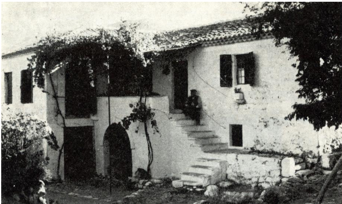
Εικόνα 30 - Σπίτι στα Πλατύστομα (1970) με εξωτερική λίθινη σκάλα που τονίζεται με «βόλτο» και λίθινο στηθαίο
