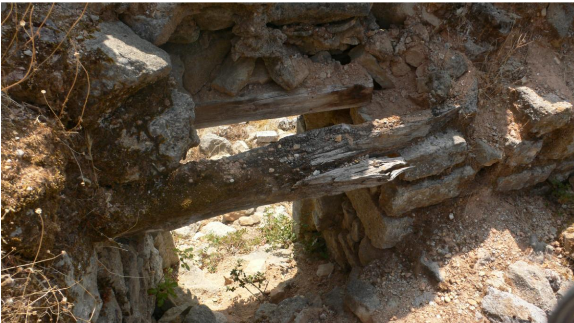
Εικόνα 117 - Νεώτερο δομημένο ξύλινο πρέκι
