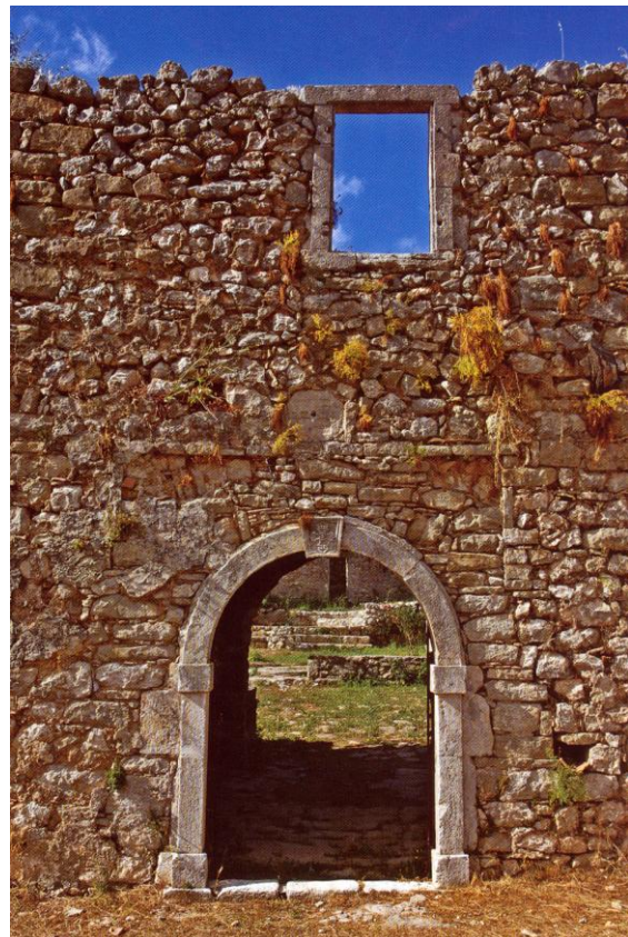
Εικόνα 60 - Η Πύλη της Ι. Μονής του Αγίου Ιωάννη Προδρόμου Καρυάς (πριν τις εργασίες αποκατάστασης)
