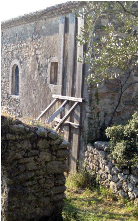
Εικόνα 126 - Πρόχειρες ξύλινες αντιστηρίξεις στον νότιο τοίχο που σήμερα έχουν απομακρυνθεί
