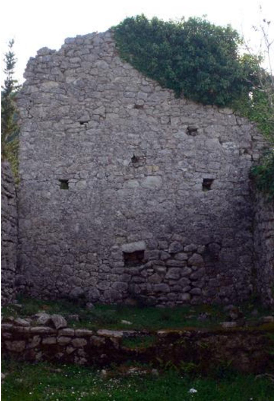
Εικόνα 148 - Ο δυτικός εγκάρσιος τοίχος. Οι ξυλότρυπες των δοκών, προσδιορίζουν τις διαστάσεις της στέγης
