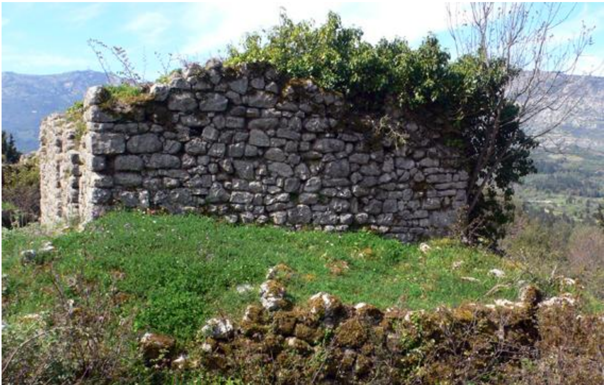
Εικόνα 179 - Βόρεια όψη κτηρίου Α.
