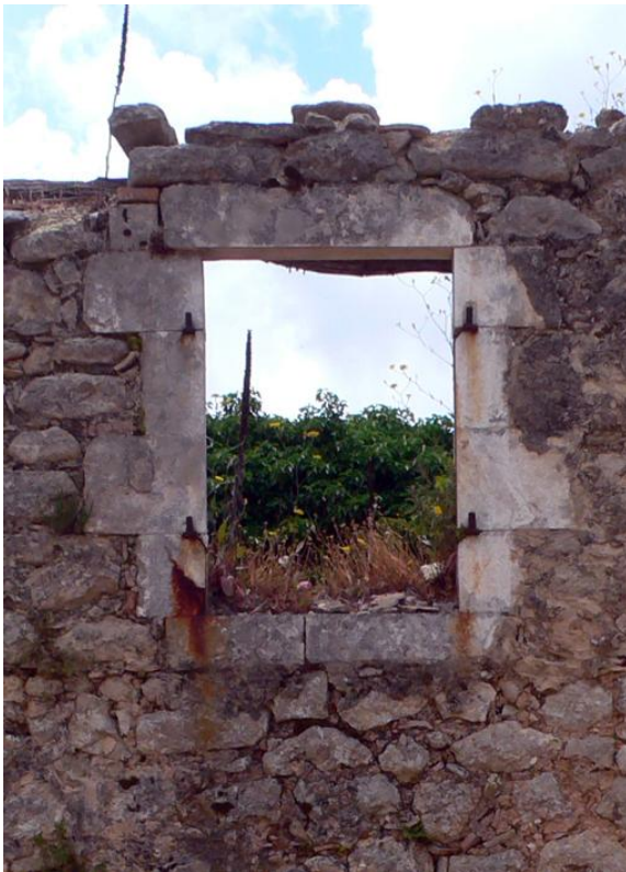
Εικόνα 150 - Εκδήλωση σκουριάς από τους σιδερένιους εξωτερικούς μεντεσέδες
