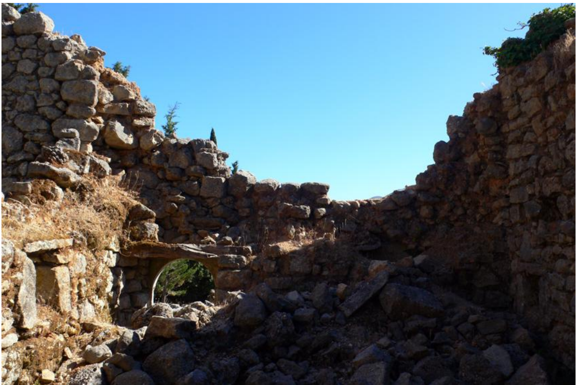
Εικόνα 191 - Αποκόλληση της εσωτερική παρειάς του τοίχου
