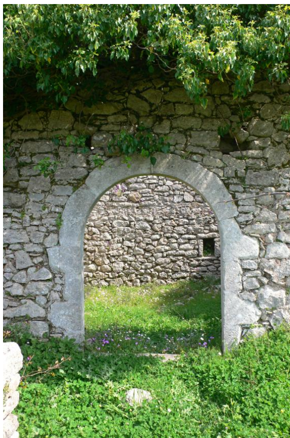
Εικόνα 187 - Λεπτομέρεια εισόδου στο δυτικό τμήμα του συγκροτήματος των κελιών
