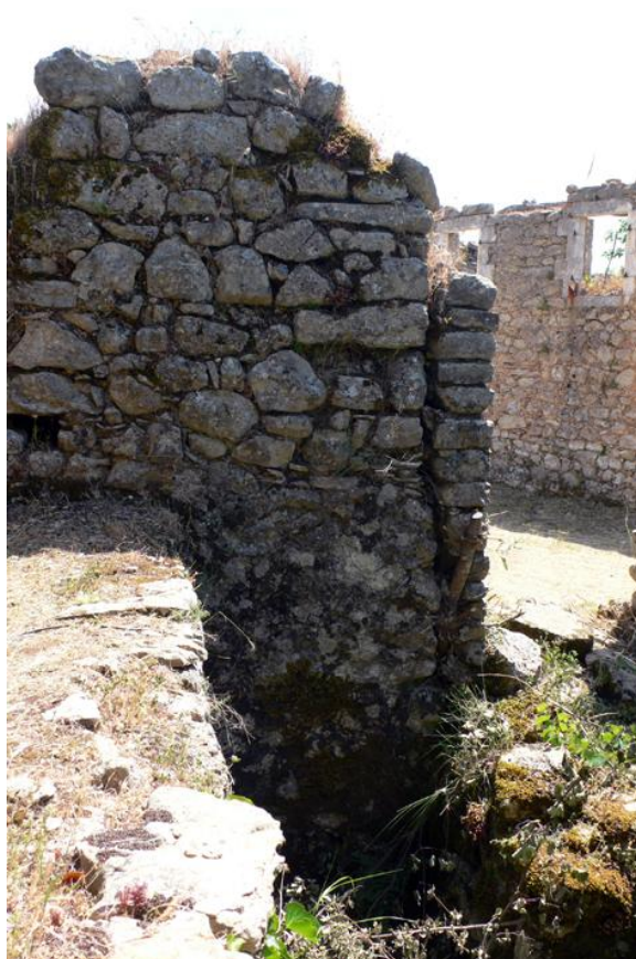
Εικόνα 95 - Λεπτομέρεια μειούμενου παλαιότερου ανοίγματος
