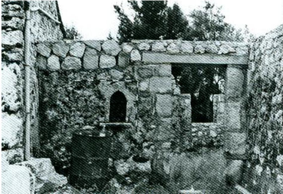
Εικόνα 31 - Θυρίδες με διπλής καμπυλότητας τόξα στον Άγιο Ιωάννη στο Ροδάκι, από τις εργασίες αποκατάστασης
