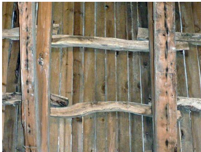
Εικόνα 146 Τηγίδες στο Καθολικό από φυσική ξυλεία
