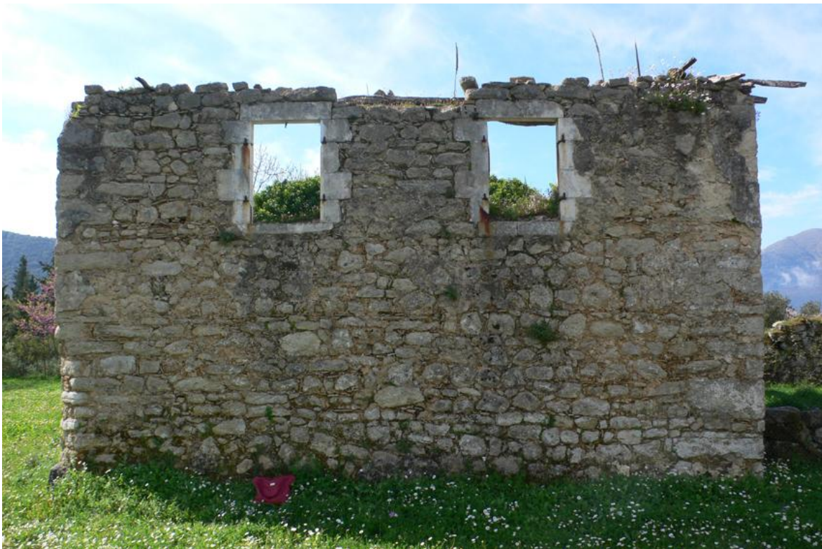
Εικόνα 185 - Βόρεια όψη κτηρίου Β
