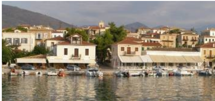
Οι τέντες αποκρύπτουν πλήρως τα στοιχεία των όψεων των ιστορικών κτιρίων.
