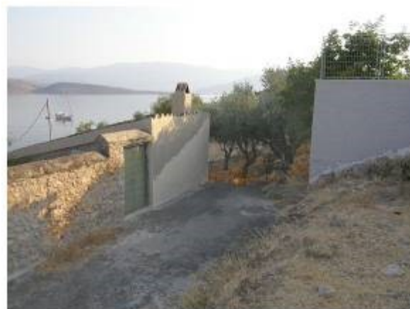
Εικ. 9: Η νεώτερη διαπλάτυνση του ιδιωτικού "δρόμου" προκάλεσε υψομετρική διαφορά μεγαλύτερη του 1 μ.
