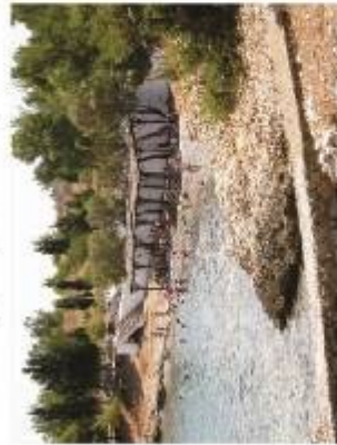
ΕΙΚ.7: Ο τοίχος αντιπληρώσεως των επιχώσεων για την κατασκευή του δρόμου.
