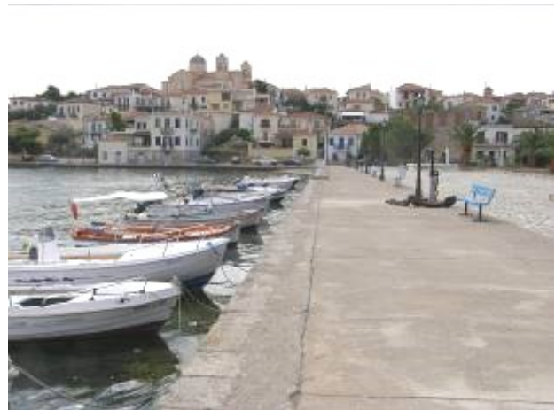
Ο άξονας του μετώπου του κρηπιδώματος
