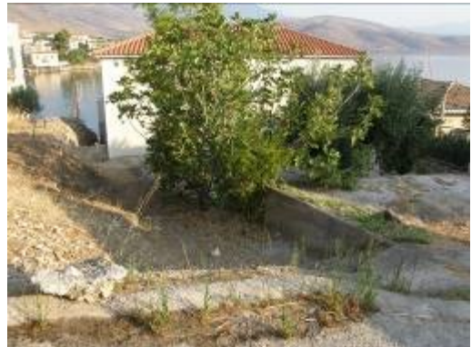
Περιοχή Κάβου: Οι ισοπεδώσεις του κενού χώρου με πρόχειρες επιστρώσεις σκυροδέματος, για τη διαμόρφωση χώρων στάθμευσης, έχουν αλλοιώσει το παλιό μονοπάτι και έχουν προκαλέσει μεγάλη υψομετρική διαφορά η οποία δυσχεραίνει την κάθοδο.
