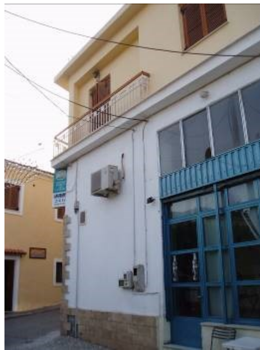
Ασύμβατο νέο κτίριο
