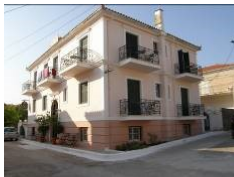
Ξενοδοχείο στην περιοχή του Χηρόλακα
