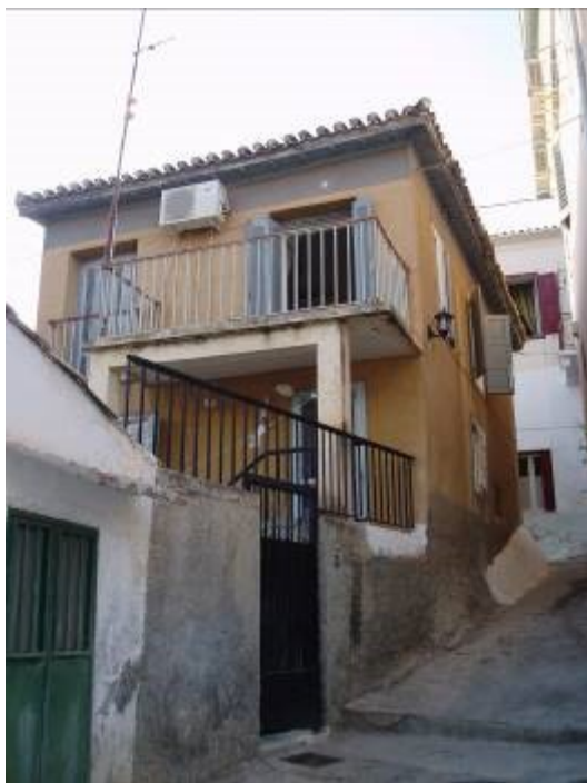
Ασύμβατη προσθήκη σε ιστορικό κτίριο
