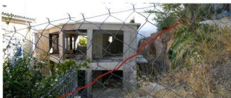
Εικ. 3: Σύγχρονες εκσκαφές σε αντιπαραβολή με την παραδοσιακή θεμελίωση στο φυσικό βράχο.
