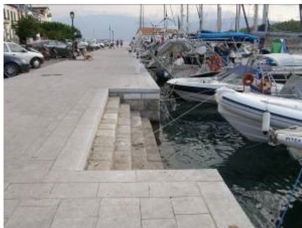
Οι νέες επιστρώσεις στην προκουμαία του κεντρικού λιμανιού. Διατηρούνται τα παλιά λίθινα σκαλοπάτια.
