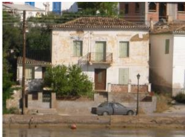
Εικ. 2: Αστικό κτίριο στην περιοχή του Χηρόλακα
