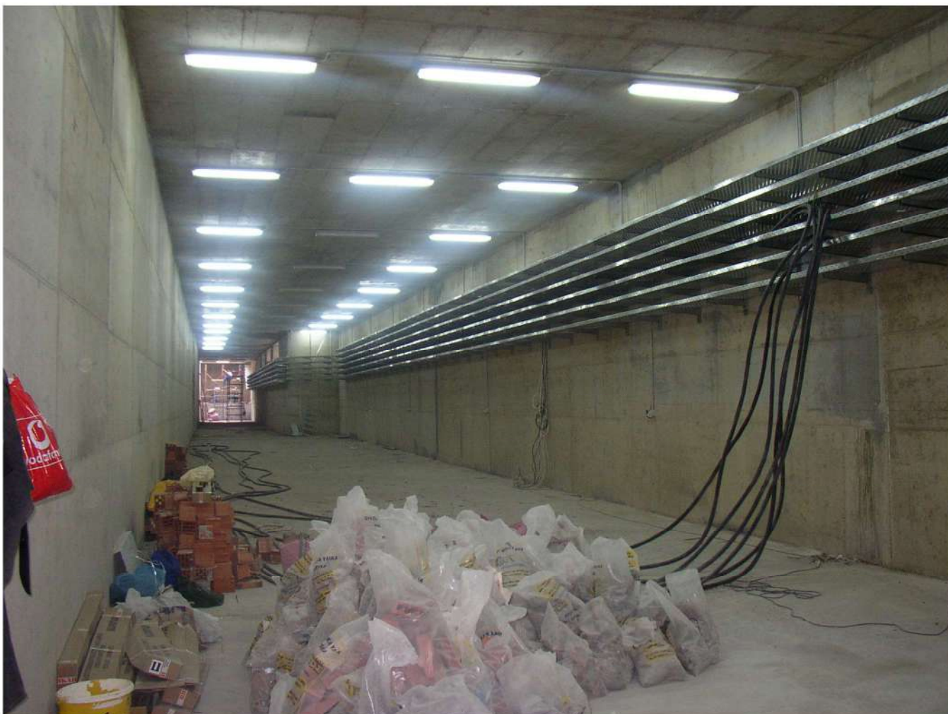
Εκσκαφή στον περίβολο του Μουσείου επί της οδού Βασιλέως Ηρακλείου, για τη δημιουργία υπόγειου χώρου Η/Μ εγκαταστάσεων.
