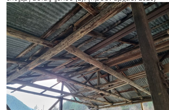
Κατασκευαστικές λεπτομέρειες σε εργοστάσιο επεξεργασίας ξύλου (3), (προσ. αρχείο, 2023)
