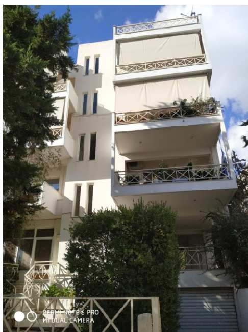
Σχήμα 2.1: Άποψη της κατασκευής προς αποτίμηση
