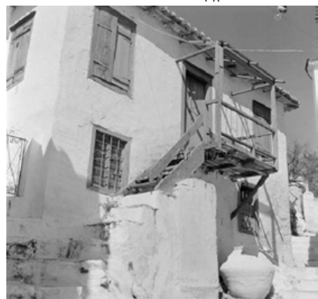
21. Κατοικία με εξώστη τύπου (β), Η οικία του Ζ. Οικονόμου, 1961, Αρχείο ΕΛΙΑ.
