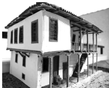
20. Κατοικία με εξώστη τύπου (α), 1869, Αρχείο "StoneVilla".
