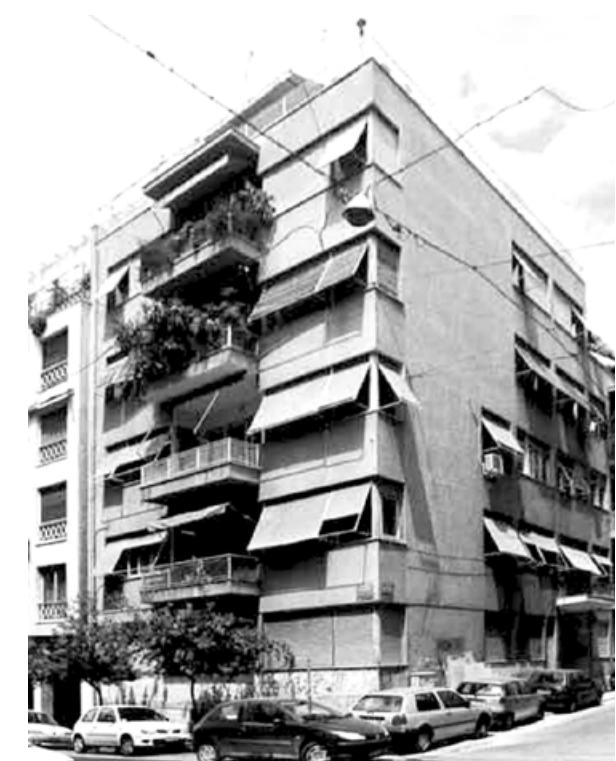
44. Πολυκατοικία στη συμβολή των οδών Μαυρομιχάλη και Ναυαρίνου (Β. Δούρας, 1936), Αρχείο Β. Κολώνας.
