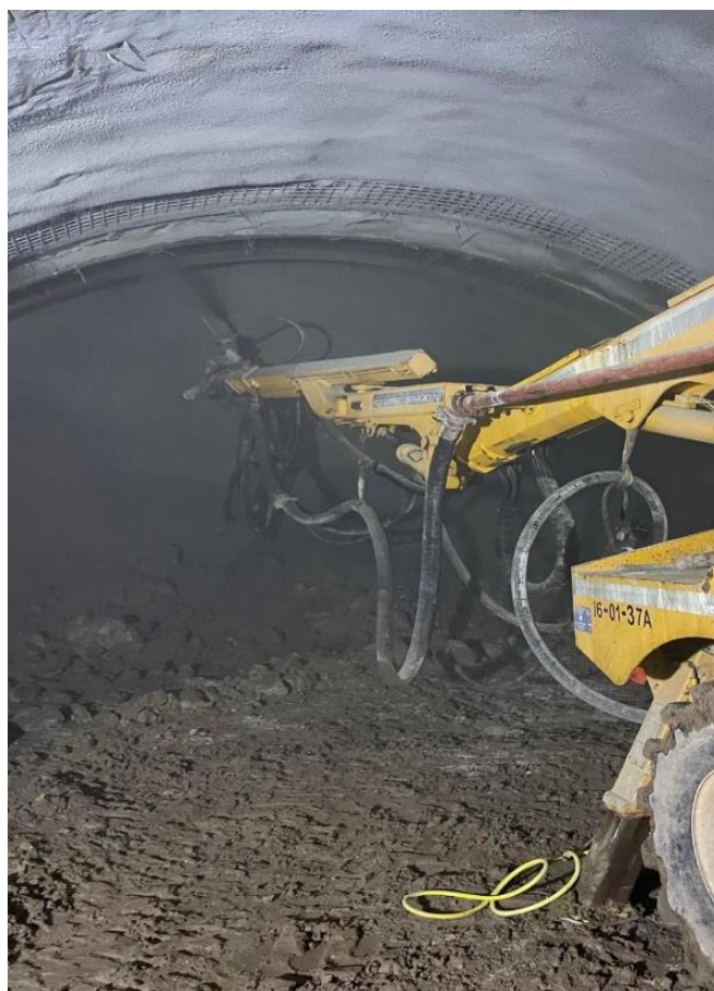
Εικόνα 2.3: Χρήση εκτοξευόμενου σκυροδέματος περιμετρικά της εκσκαφής.
