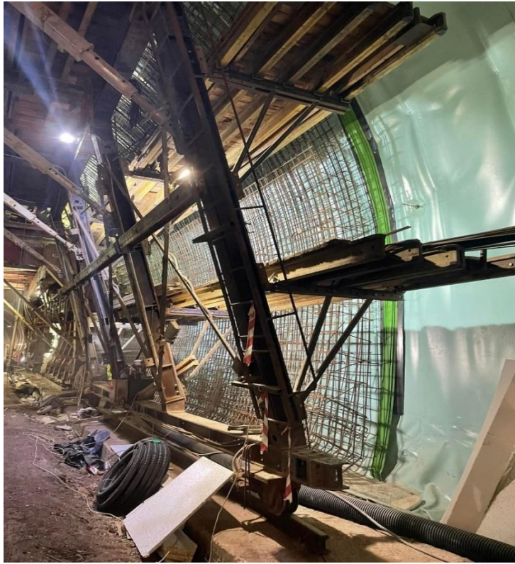
Εικόνα 2.8 Μεταλλότυπος έγχυσης σκυροδέματος κατά τη φάση κατασκευής.
