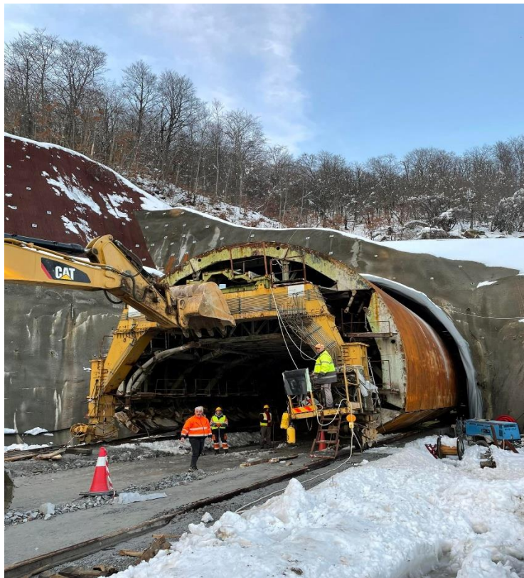
Εικόνα 2.7: Μεταλλότυπος έγχυσης σκυροδέματος πριν την είσοδό του στη σήραγγα.
