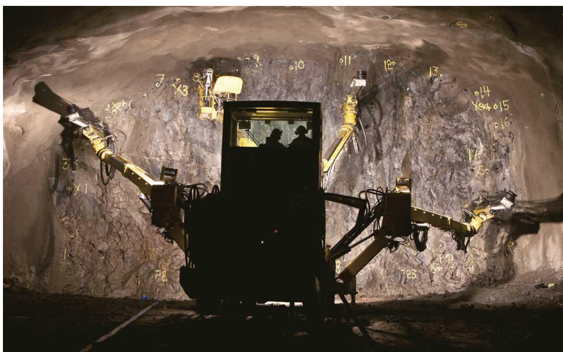
Εικόνα 2.1: Διάτρηση οπών με διατρητικό μηχάνημα για ανατίναξη του μετώπου ( https://tunnelingonline.com ).
