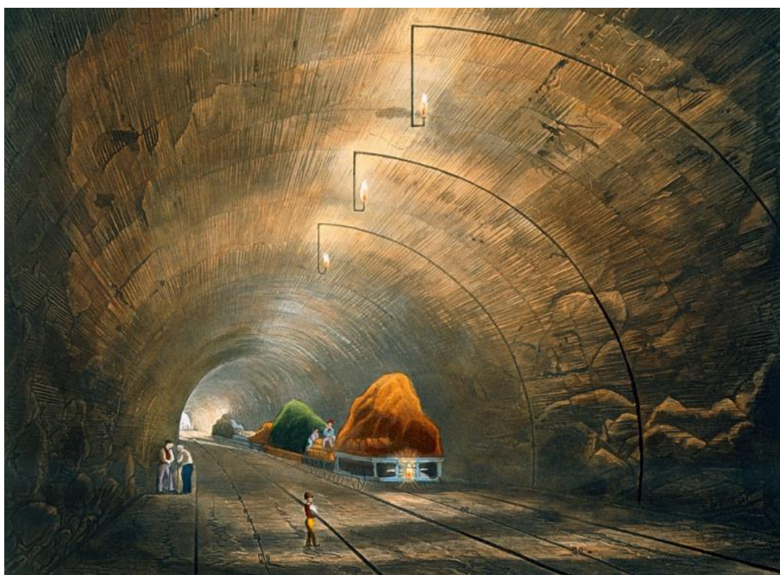
Εικόνα 1.3: Σήραγγα Wapping μήκους 2030 μέτρων που κατασκευάστηκε για τη σιδηροδρομική ένωση Λίβερπουλ και Μάντσεστερ (Σοφινός, 2018).
