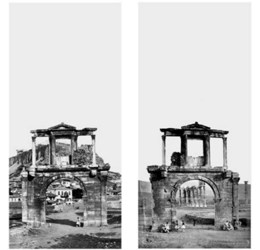
Εικόνα 27. Πύλη του Αδριανού, ΒΔ και ΝΔΠλευρά, 1865 _ Άγνωστος Φωτογράφος
