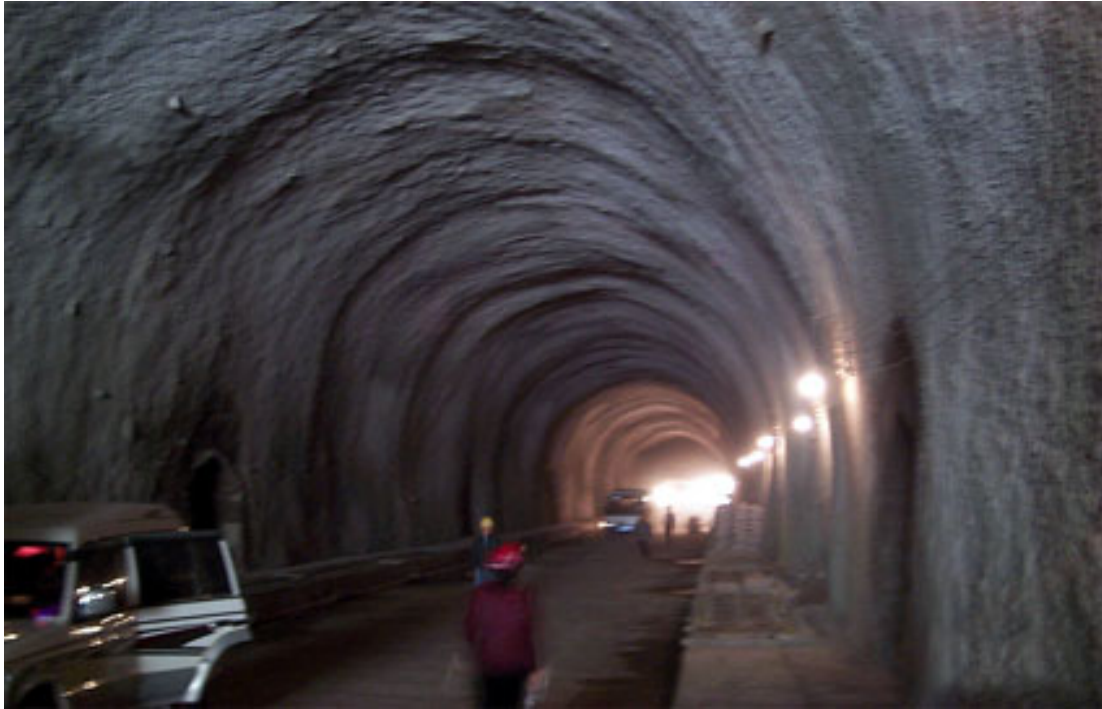
Εικόνα 3.2 – Το εκτοξευόμενο σκυρόδεμα ως μέσο προσωρινής υποστήριξης.
