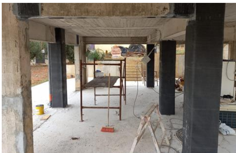
Σχήμα 4.4: Τοποθέτηση υφασμάτων ινοπλισμένων πολυμερών σε υποστυλώματα και κόμβους. ( www.eletech.gr )
