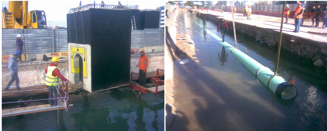
(a) Εργασίες κατά την εκτροπή των δικτύων
