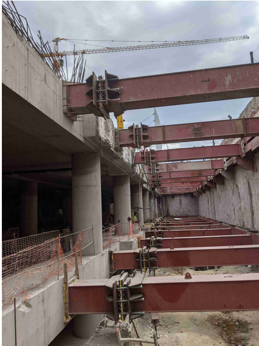
Εικόνα 3.9: Καθαίρεση Δ.Τ για την διάνοιξη της πρόσβασης 2
