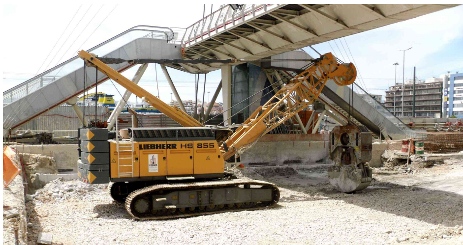
Εικόνα 3.5: Μηχανική αρπάγη κατά την εκσκαφή του Δ.Τ
