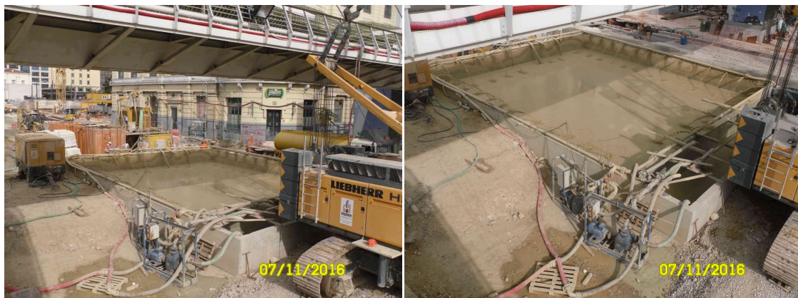
Εικόνα 3.4: Δεξαμενές τροφοδοσίας αιωρήματος μπεντονίτη για την υποστήριξη της εκσκαφής των Δ.Τ
