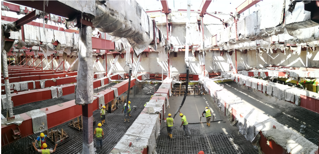
Εικόνα 3.11: Διάταξη αντηρίδων στο σκάμμα εκσκαφής του σταθμού
