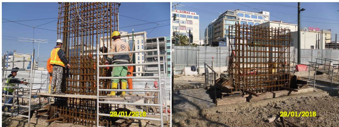
Εικόνα 3.6: Ένωση δύο κλωβών οπλισμού μεταξύ τους κατά τη διάρκεια τοποθέτησης του οπλισμού
