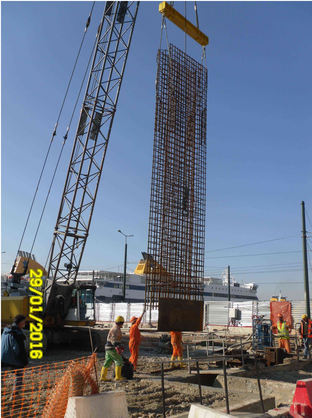
Εικόνα 3.7: Τοποθέτηση κλωβού οπλισμού
