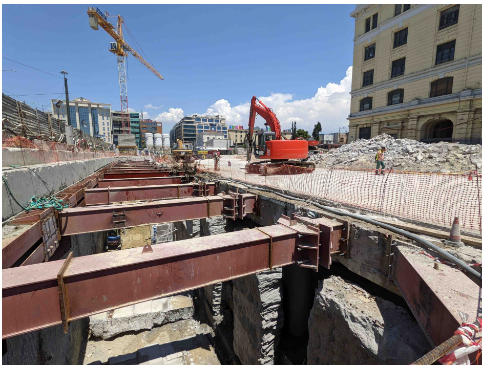
Εικόνα 2.10: Πρόσβαση 2 του σταθμού κατά το στάδιο εκσκαφής της
