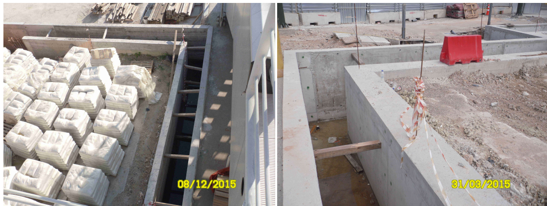
Εικόνα 3.3: Οδηγά τοιχώματα των διαφραγματικών τοίχων στο εργοτάξιο του σταθμού Πειραιά
