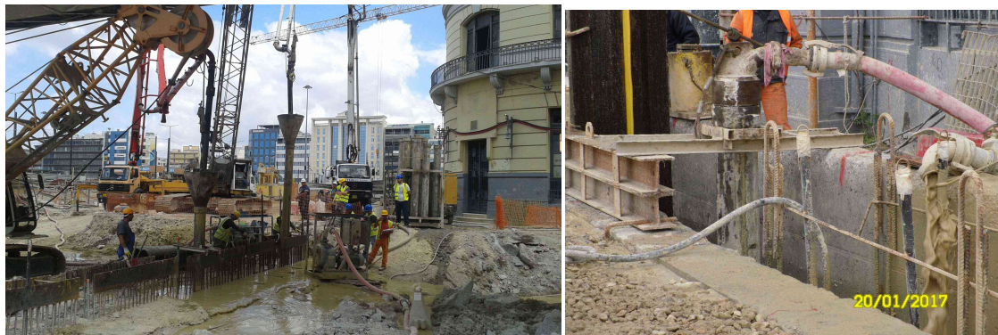
Εικόνα 3.8: Σκυροδέτηση διαφραγματικών τοίχων
