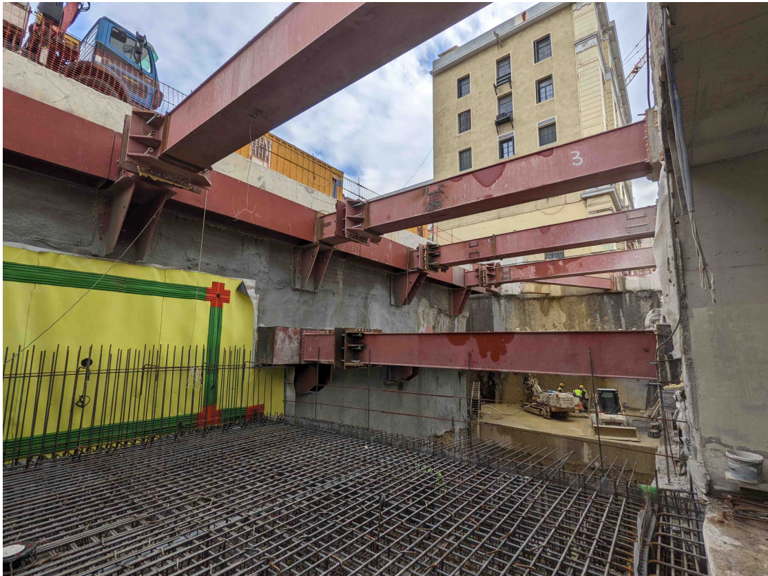
Εικόνα 2.11: Πρόσβαση 3 του σταθμού κατά το στάδιο εκσκαφής της
