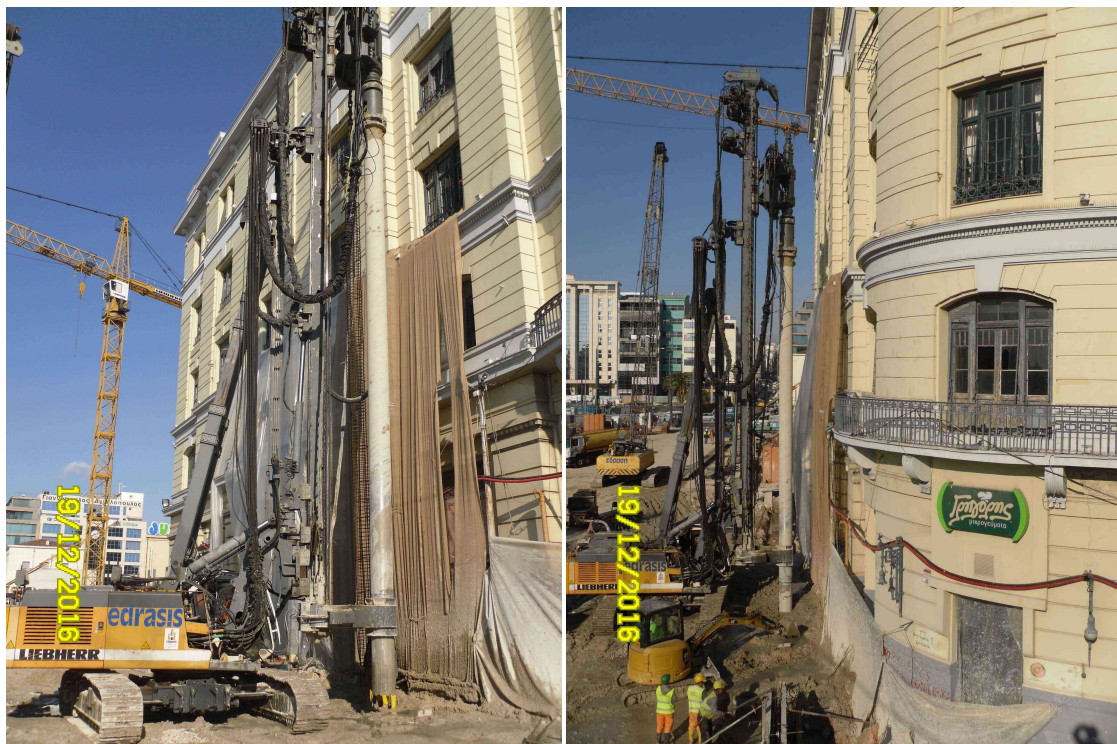
Εικόνα 3.12: Τοποθέτηση των πασσάλων έμπροσθεν του ΗΣΑΠ
