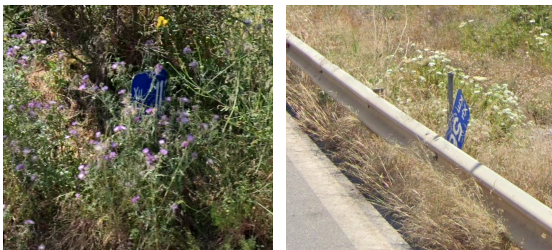
Εικόνα 4.9: Χιλιομετρικός δείκτης στην Χ.Θ.11+000, κρυμμένος από την βλάστηση & στην Χ.Θ.56+000, σχεδόν πεσμένος
