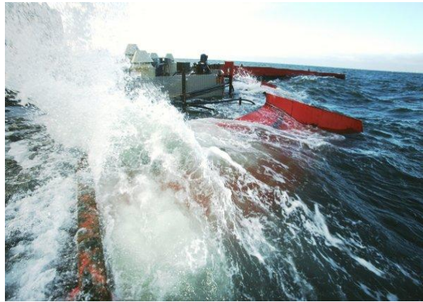
Εικόνα 3.6.4.: Το πρωτότυπο μοντέλο Wave Dragon κλίμακας 1:4.5 στο Nissum Brending της Δανίας.
