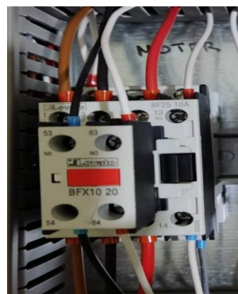
Σχήμα 37. Ρελε ισχύος (G)
