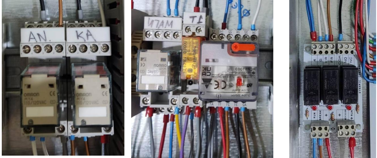
Σχήμα 40. Βοηθητικά ρελέ πίνακα
