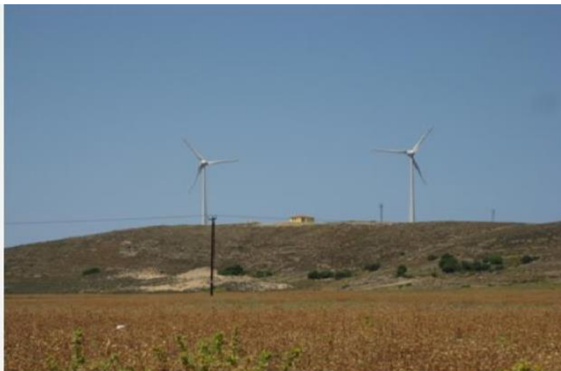
Εικόνα 44: Οι ανεμογεννήτριες ENERCON E-44 της Δ.Ε.Η. Ανανεώσιμων Πηγή: https://www.ppcr.gr/el/
