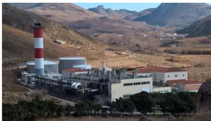
Εικόνα 41: Αυτόνομος Σταθμός Παραγωγής Λήμνου.
