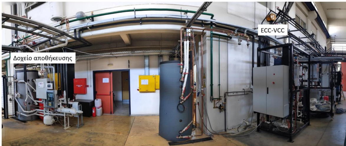
Εικόνα 5: Διασύνδεση δοχείου αποθήκευσης θερμότητας με σύστημα ECC
