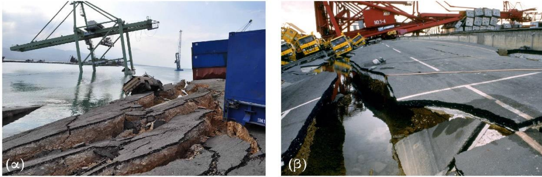
Εικόνα 1 – Τμήματα λιμένα που υπέστησαν ζημιές μετά από σεισμό (α) στο Port-au-Prince Πηγή: (Berkeley Seismology Lab, 2010), (β) στο Kobe Πηγή: (UCDAVIS Civil and Environmental Engineering)
