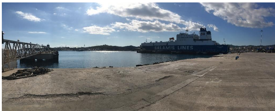
Εικόνα 10 - Άποψη τομέα ακτοπλοΐας (λήψη φωτογραφίας κατά την επιτόπια επιθεώρηση της ομάδας του Εργαστηρίου Λιμενικών Έργων, Φεβρουάριος, 2020)
