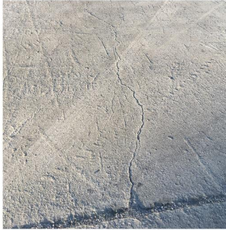
Εικόνα 24 - Παραδείγματα ρωγμών (λήψη φωτογραφίας κατά την επίτοπια επιθεώρηση της ομάδας του Εργαστηρίου Λιμενικών Έργων, Φεβρουάριος, 2020)
