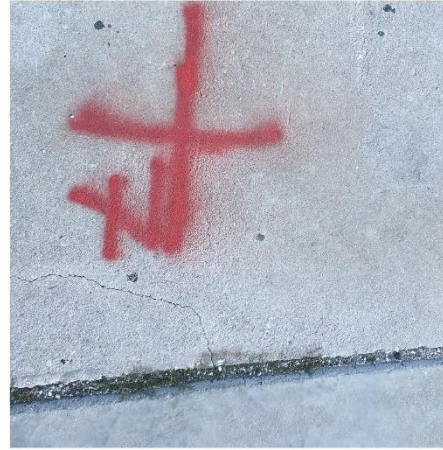
Εικόνα 24 - Παραδείγματα ρωγμών (λήψη φωτογραφίας κατά την επίτοπια επιθεώρηση της ομάδας του Εργαστηρίου Λιμενικών Έργων, Φεβρουάριος, 2020)
