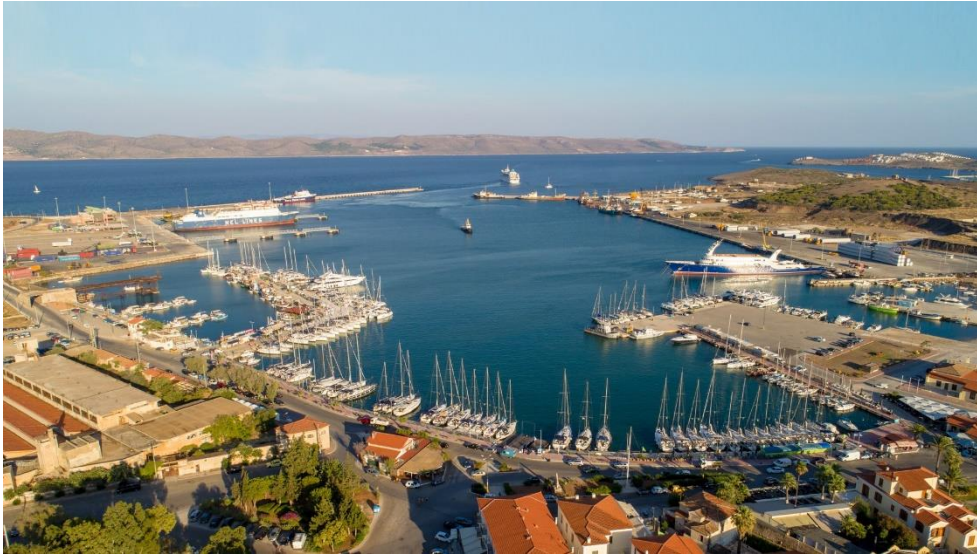
Εικόνα 7 - Λιμένας Λαυρίου (δυτική λήψη) Πηγή: (Οργανισμός Λιμένος Λαυρίου, 2023)
