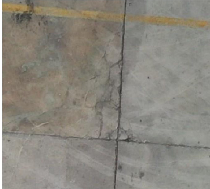
Εικόνα 21 - Παράδειγμα (2) εντοπισμού φυσικής φθοράς από την οπτική επισκόπηση στον Ορθοφωτοχάρτη στην πλάκα σκυροδέματος από την πτήση UAV Πηγή: (Εργαστήριο Λιμενικών Έργων, 2022)
