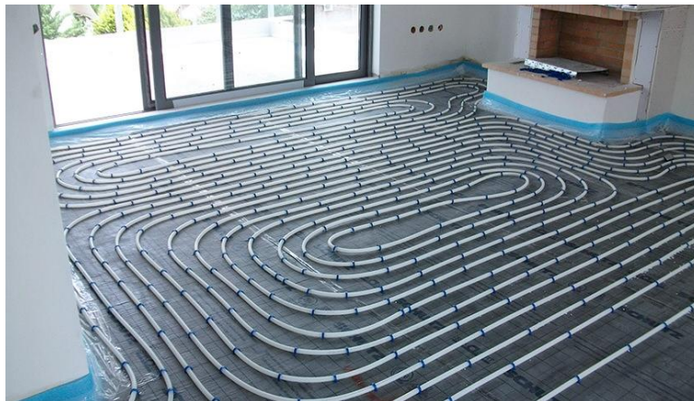
Εικόνα 2-3 Σωληνώσεις ενδοδαπέδιας θέρμανσης
