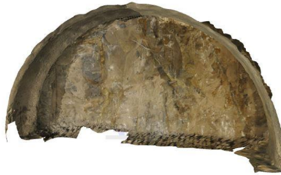
Εικόνα 3-4. 3D χαρτογράφηση μετώπου και προσωρινής επένδυσης με την τεχνολογία LiDAR (Schubert, W., & Moritz, A. B., 2014).
