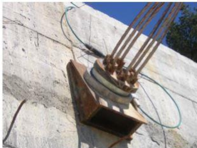
Εικόνα 3-25. Εγκατάσταση κυψέλης φορτίου σε αγκύριο. (Μπίκος, Χ. 2019).
