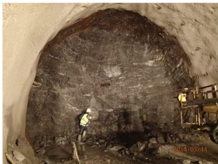
Εικόνα 3-3. Καταγραφή του προσανατολισμού και της θέσης των ασυνχειών με γεωλογική πυξίδα – κλινόμετρο σε μέτωπο εκσκαφής (Schubert, W., & Moritz, A. B., 2014).
