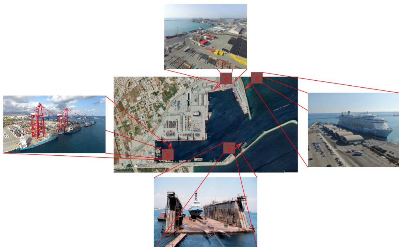
Σχήμα 5.1: Γενική φωτογραφική τεκμηρίωση λιμένα Λεμεσού
