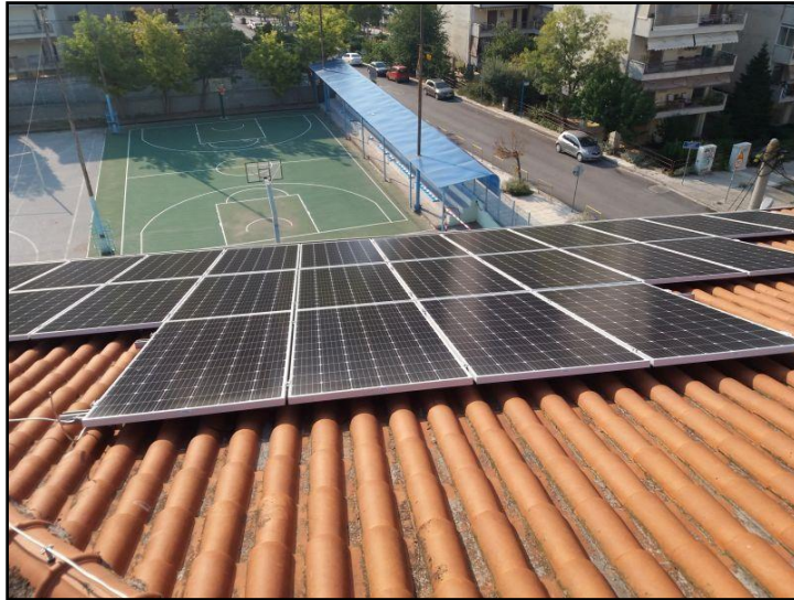
Εικόνα 6.22. Παράδειγμα φωτοβολταϊκών πάρκων σε σχολείο του Δήμου Καλαμαριάς Πηγή: kalamaria.gr
