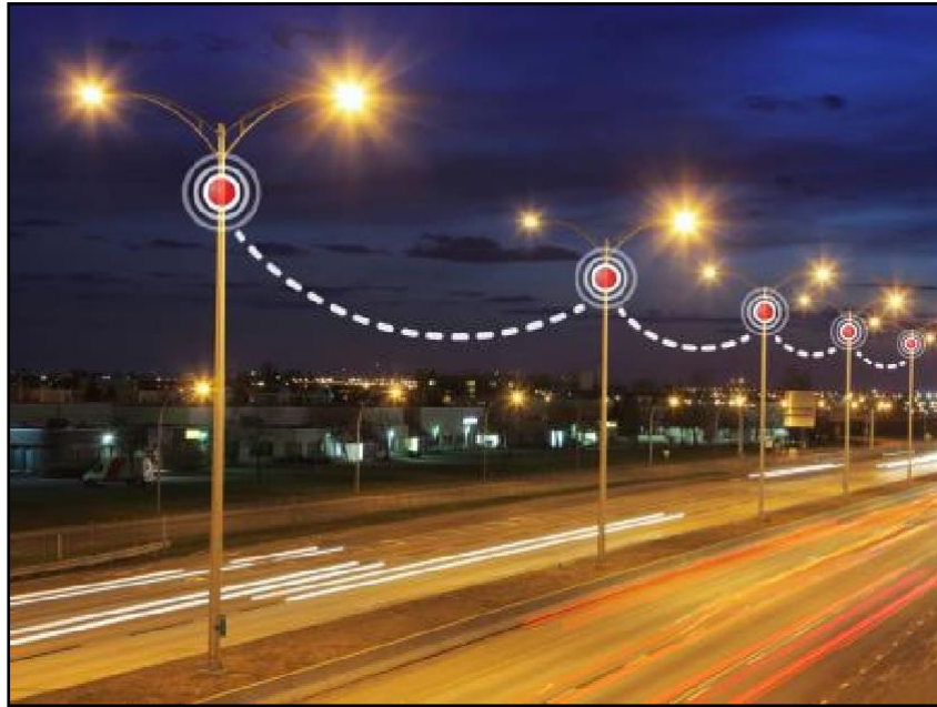
Εικόνα 6.21. Σύστημα διαχείρισης ηλεκτροφωτισμού με LEDs Πηγή: arta.gr
