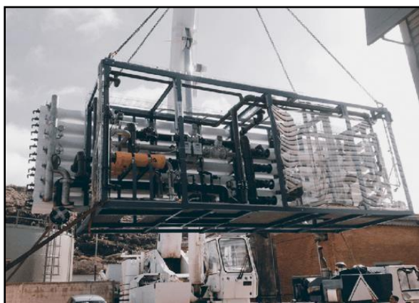
Εικόνα 2.21. Το νέο σύστημα αφαλάτωσης αντίστροφης όσμωσης στη Παντελλερία Πηγή: protecnosrl.it
