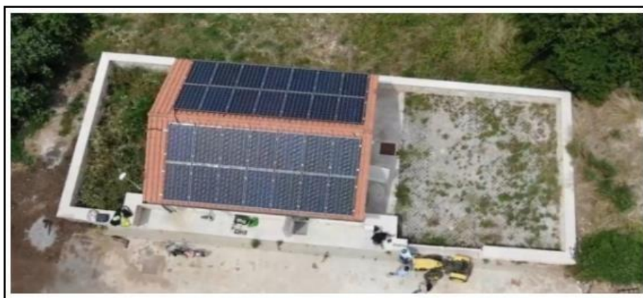
Εικόνα 2.2. Η μονάδα αφαλάτωση στο νησί Unije Πηγή: insulae-h2020.eu
