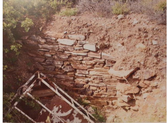
Εικόνα 37 Φρέαρ Ρενιέρη ή Μπουγιούκα. Η πετρόχτιστη πλευρά του μεταλλευτικού φρέατος.
