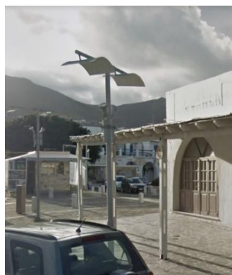
Εικόνα 57 Στύλος ηλιακού λαμπτήρα με πάνελ στο λιμάνι της Παροικιάς, Πάρου. Πηγή: Google Earth Pro
