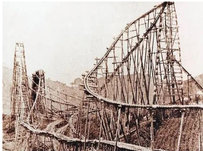
Εικόνα 2.2.2 Αγωγοί από μπαμπού που λειτουργούν με την βαρύτητα (Πηγή : www.kickassfacts.com )
