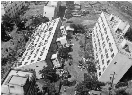
Εικόνα 1.3.3 Υπό κλίση πολυκατοικίες λόγω ρευστοποίησης στη Νιγκάτα
