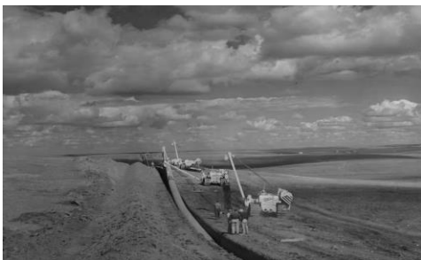
Εικόνα 2.2.3 Κατασκευή του αγωγού TransCanada, 1957 ( Πηγή : Library and Archives Canada)
