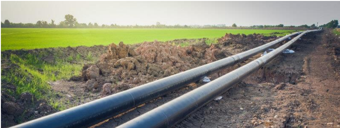
Εικόνα 2.1.1 Αγωγός υπό κατασκευή (Πηγή: www.ifsolutions.com )
