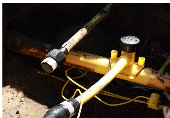
Εικόνα 2.5.2 Αγωγός διανομής Aldyl-A (Πηγή: https://njbiz.com/south-jersey-gas-touts-200m-infrastructure-program-slideshow/ )
